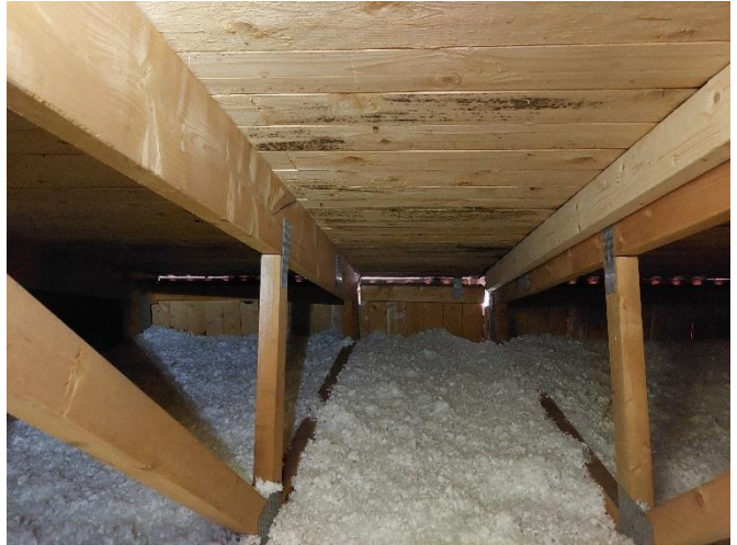
Figur 11. Tydliga otätheter i takfoten på kvarvarande huskropp.
