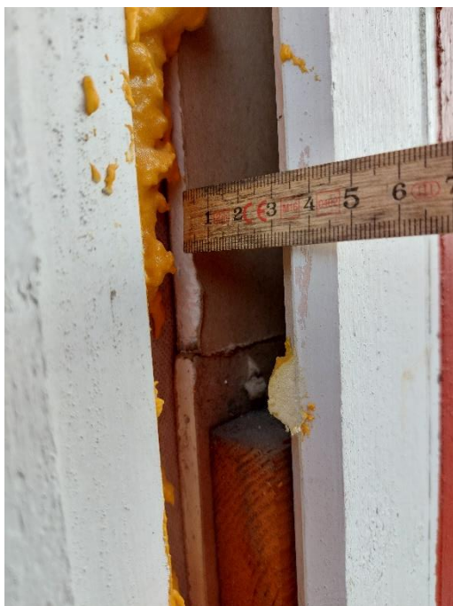
Figur 14. En luftspalt innanför ytterpanelen. Här syns även fogskummet som applicerats mellan modulerna.
