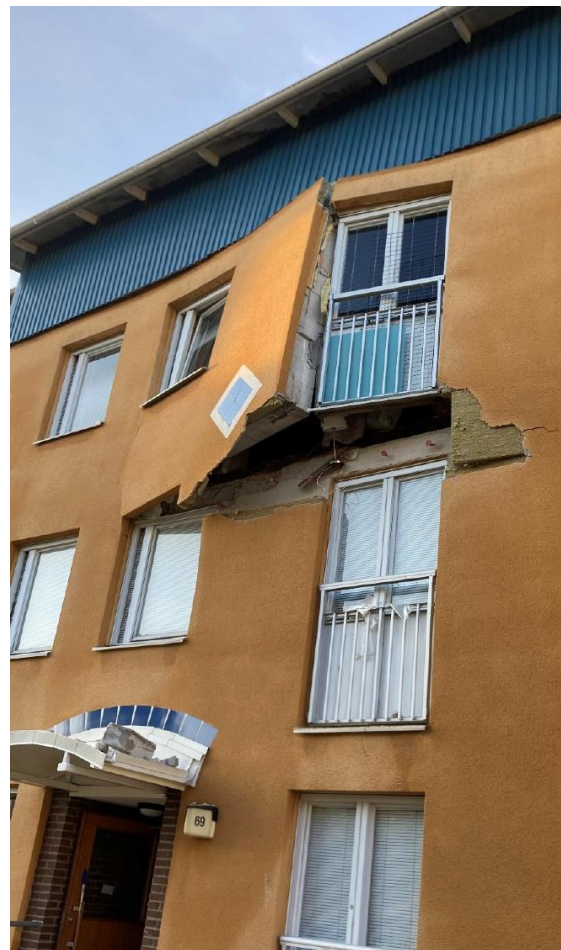
Figur 10. Ras från skadade konstruktioner är en central risk vid många sprängningar. Foto: Kristoffer Wahter
