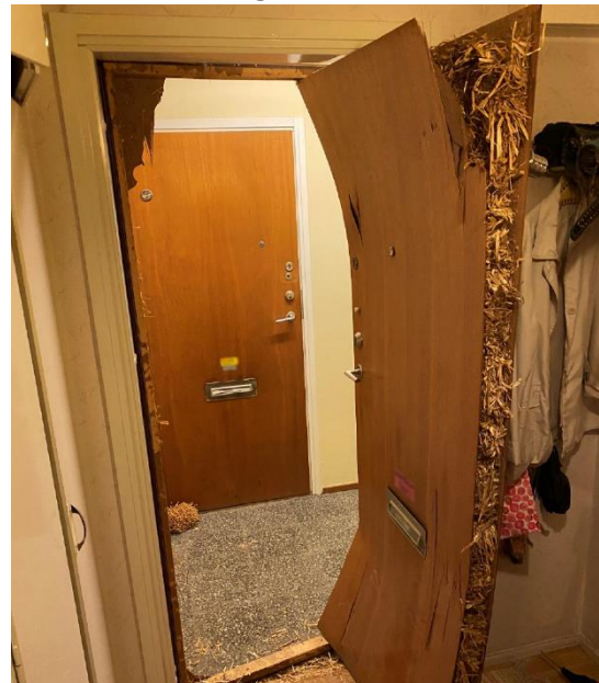
Figur 11. Vid sprängningar kan brandcellsgränser förstöras. Foto: SSBF
