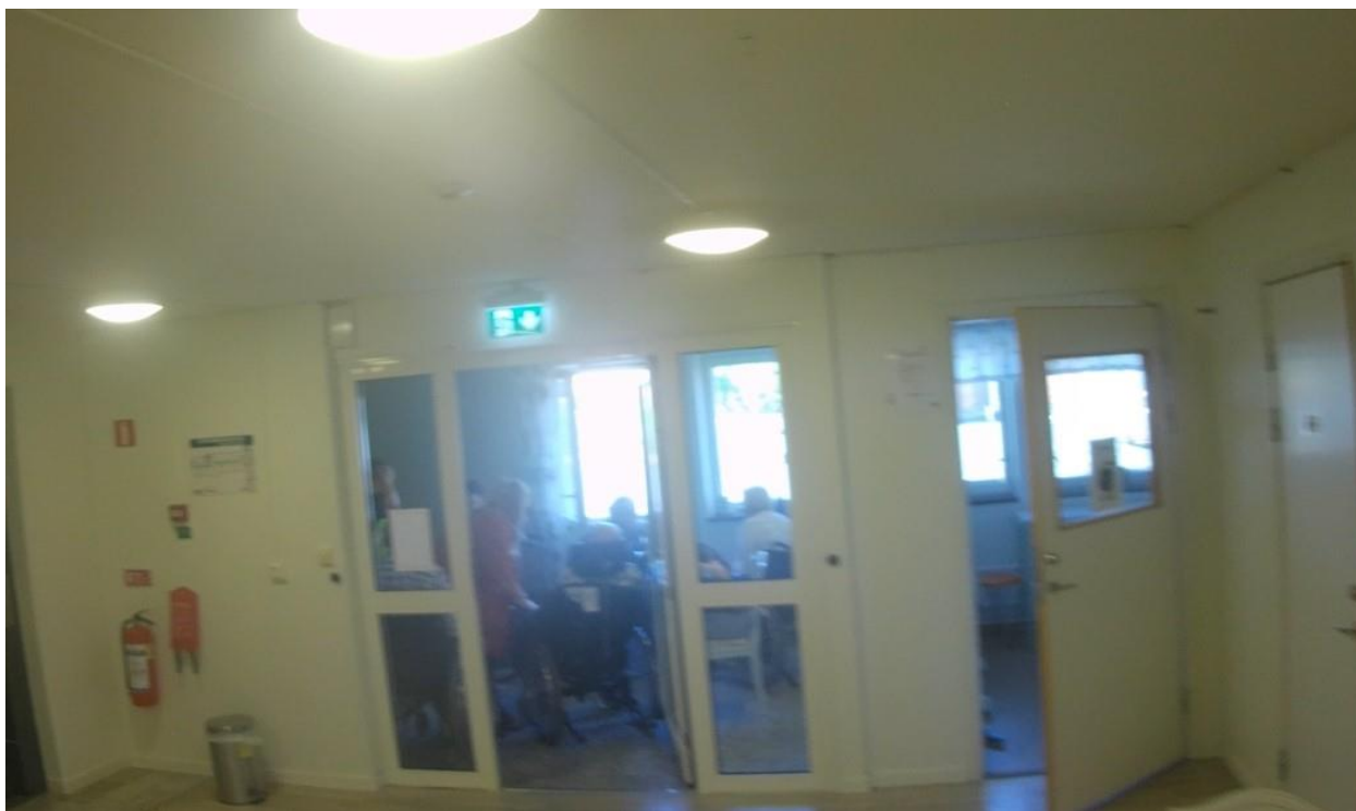
Bild 19: Utrymda personer ifrån våning 2 samlade i trapphuset, blockerar/ begränsar möjligheten att röra sig i trapphuset.
