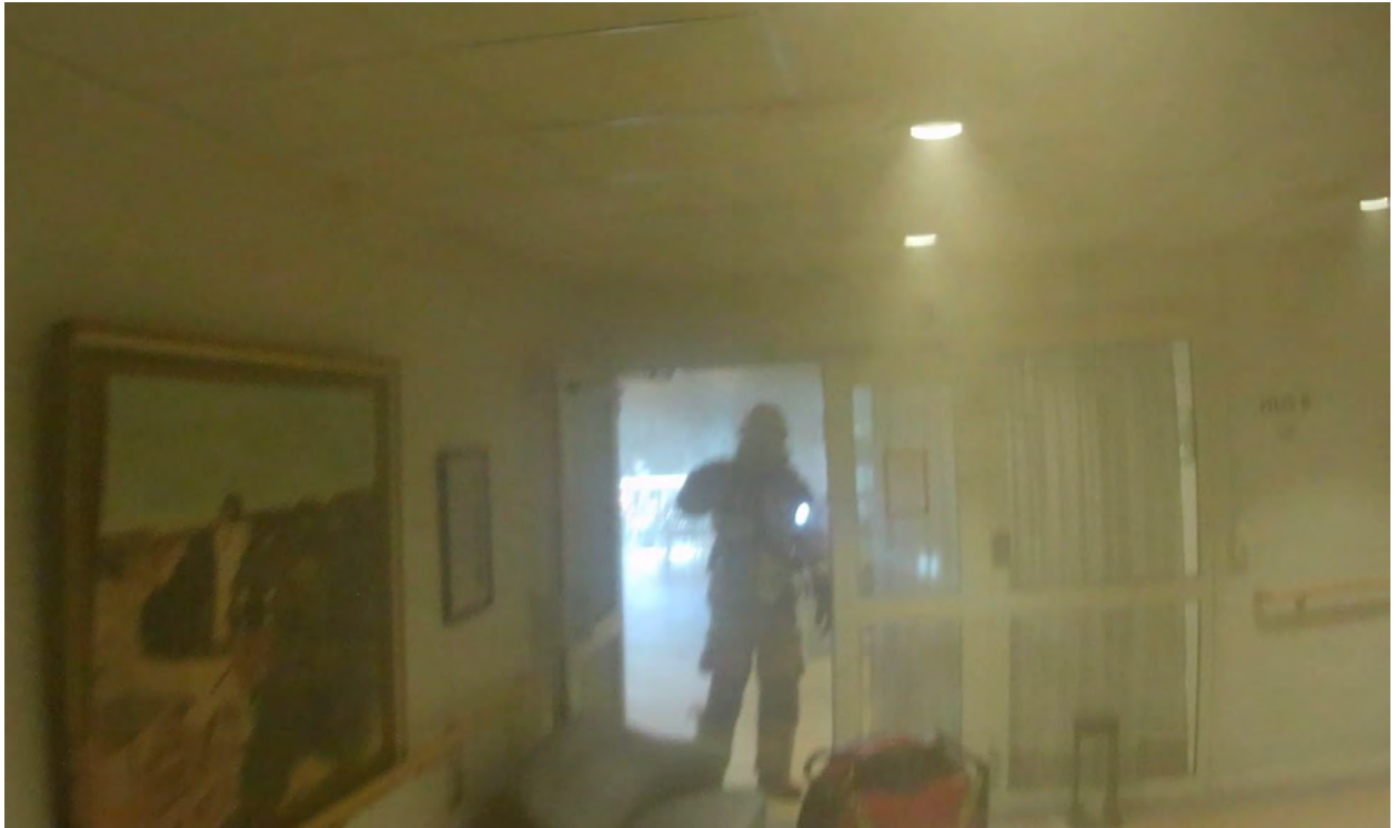
Bild 16: Uppställd dörr till samlingsrummet på våning 1, viss mängd rök läckte ut till utrymmet angränsande till trapphuset.
