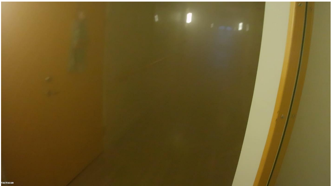
Bild 15: Korridoren på våning 3.
