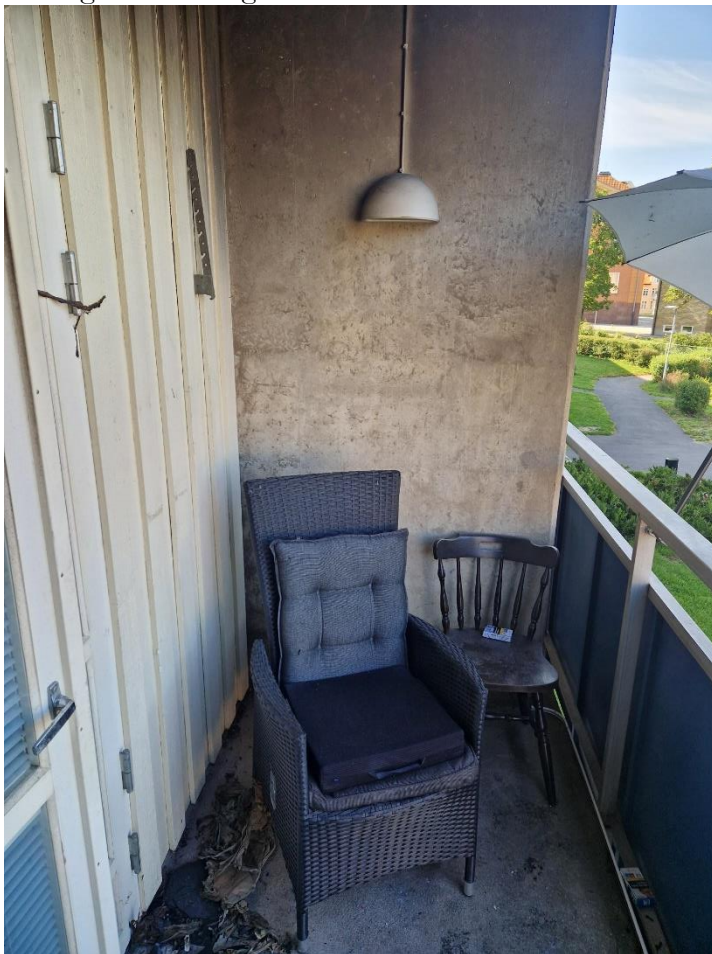
Balkongen till brandlägenheten. Här satt personen som undsattes med evakueringsbuva.
