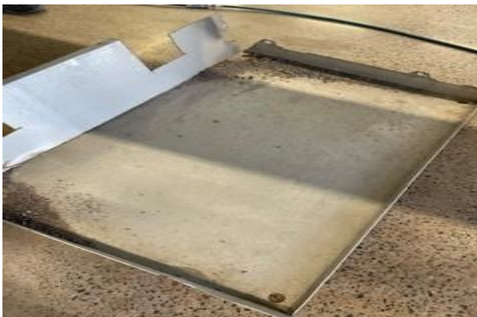
Figur 4 Skyddsplåten som skyddar tankarna efter ombyggnation (Foto RTSO)
