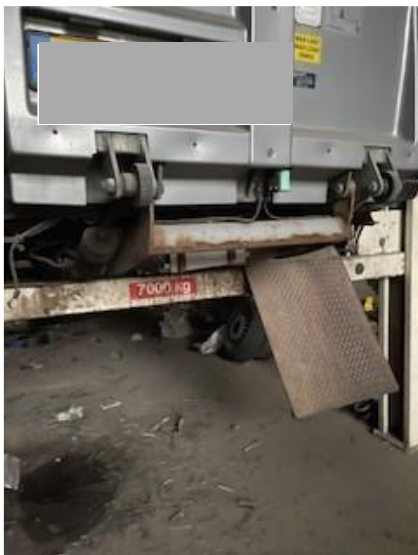
Figur 7 Skyddsplåtar från rampen har skjutits i väg i samband med explosionen i verkstaden (Foto RTSO)
