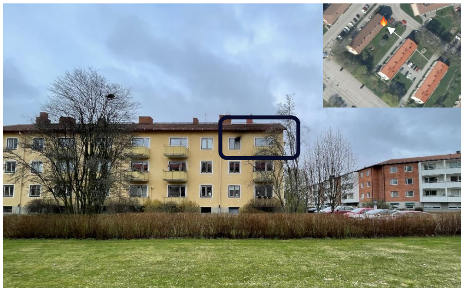
Figur 2. Byggnaden betraktad från sydost med den branddrabbade lägenheten markerad med svart ram.
