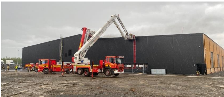
Figur 7 visar två hävare som ställts upp för att underlätta arbetet på taket. Foto taget av räddningstjänsten kl. 18.07, 2023-07-17.
