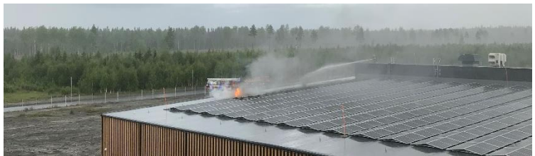
Figur 6 visar foto från hävare när brandman på taket lägger vatten mot brand i solceller. Foto taget av räddningstjänsten kl. 17.24, 2023-07-17.
