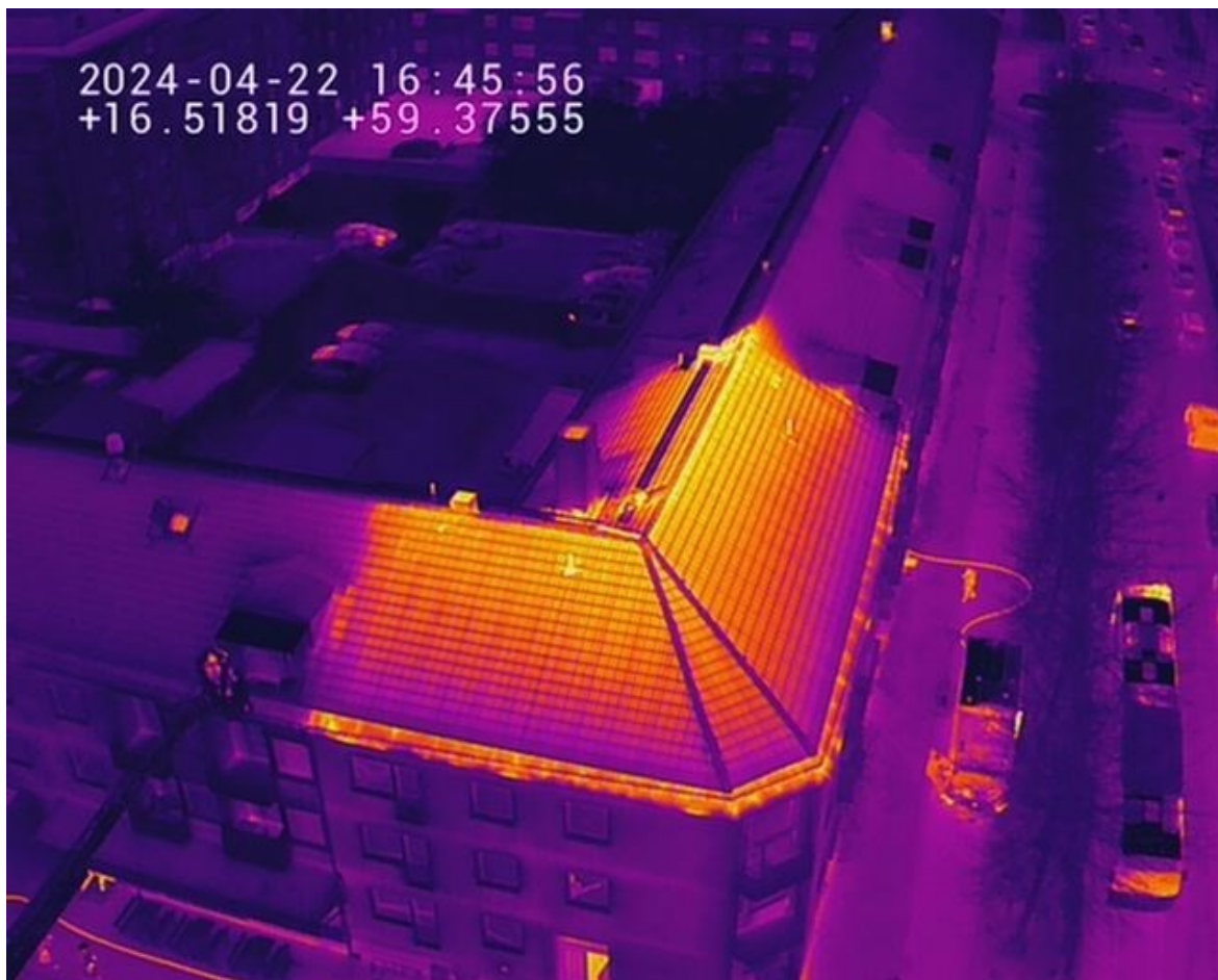
Bild 4, Drönerfoto taget med värmekamera över branddrabbad byggnad c:a 40 minuter efter räddningstjänstens ankomst, notera värmespridning i taknock mot angränsande brandcell i borte delen av vind!
