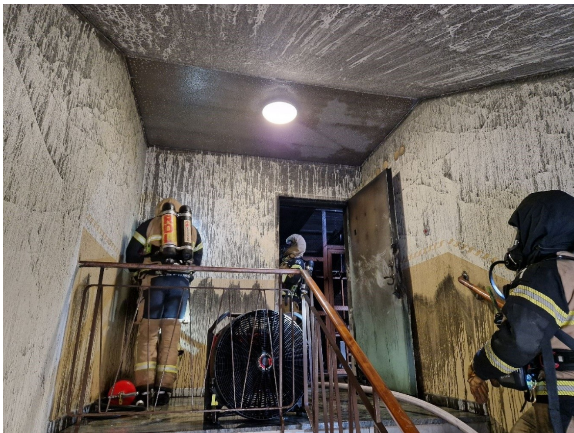
Bild 3, Angreppsväg trapphuset Västra Storgatan 2A
