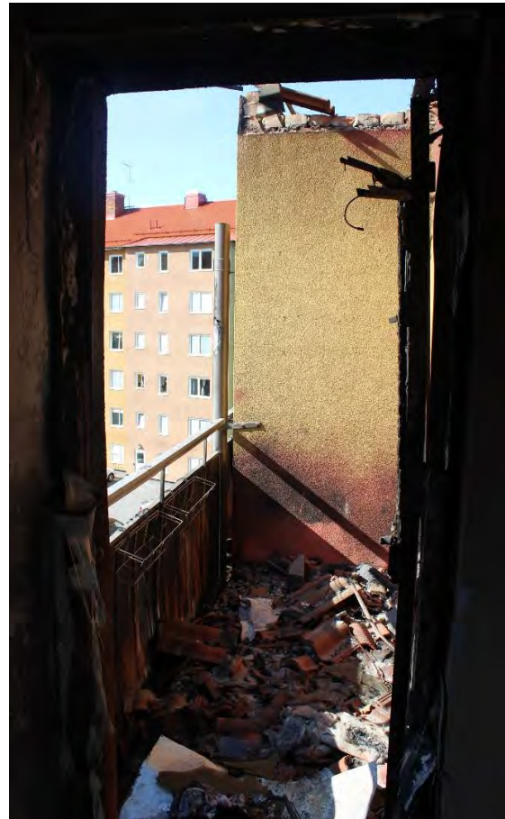
Figur 16 och 17. Figur 16 visar det mellanrum mellan ytterväggen och bärande innervägg som skapats vid en tryckvåg. Figur 17 visar dörröppning mot balkongen.
