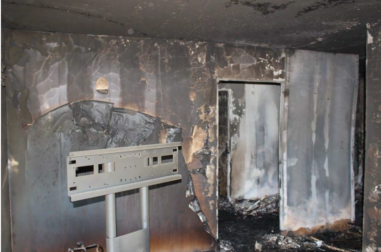
Figur 23. Bild på brandskador i rum C.
