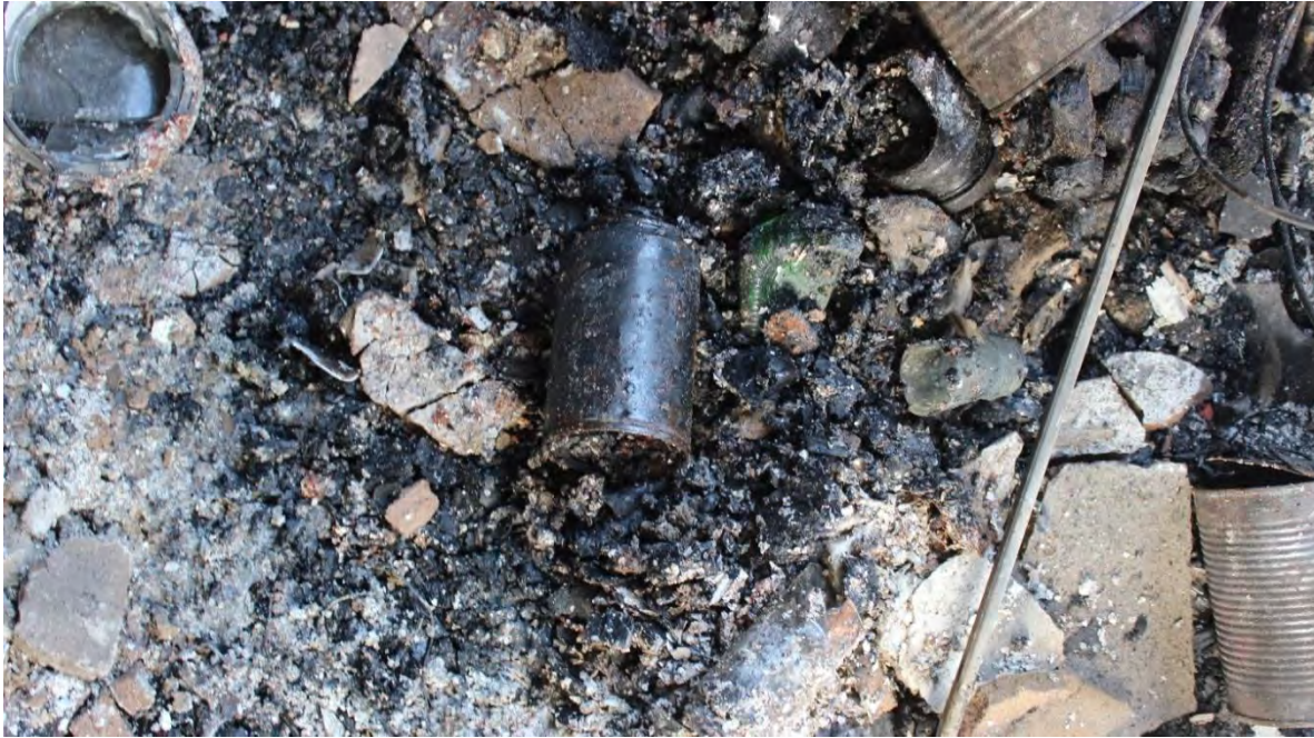
Figur 15. Bild på en sprayburk som återfanns i brandresterna vid platsen där det tidigare funnits ett köksskåp, det vill säga nära ytterväggen som tryckts ut.
