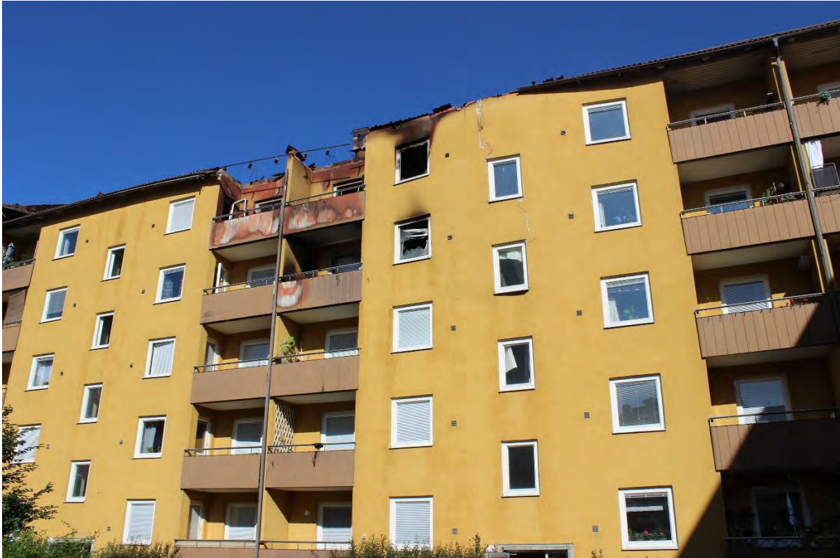
Figur 5. Bild på den branddrabbade byggnadens fasad mot innergården.
