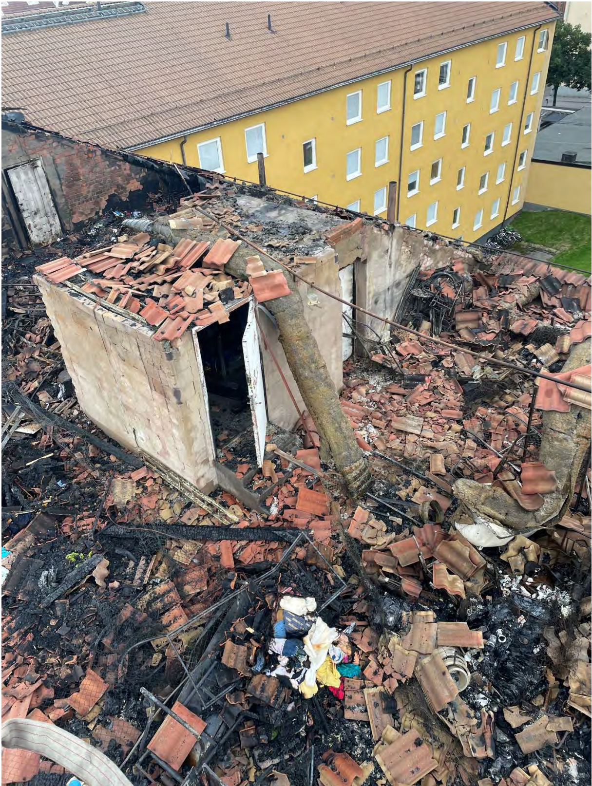
Figur 27. Bild på vinden och takkonstruktion. Trapphusen konstruktion var dragen upp i en kubisk form upp på vinden. Rök trycktes ned i trapphusen med adress Luntgatan 13C och 15A.
