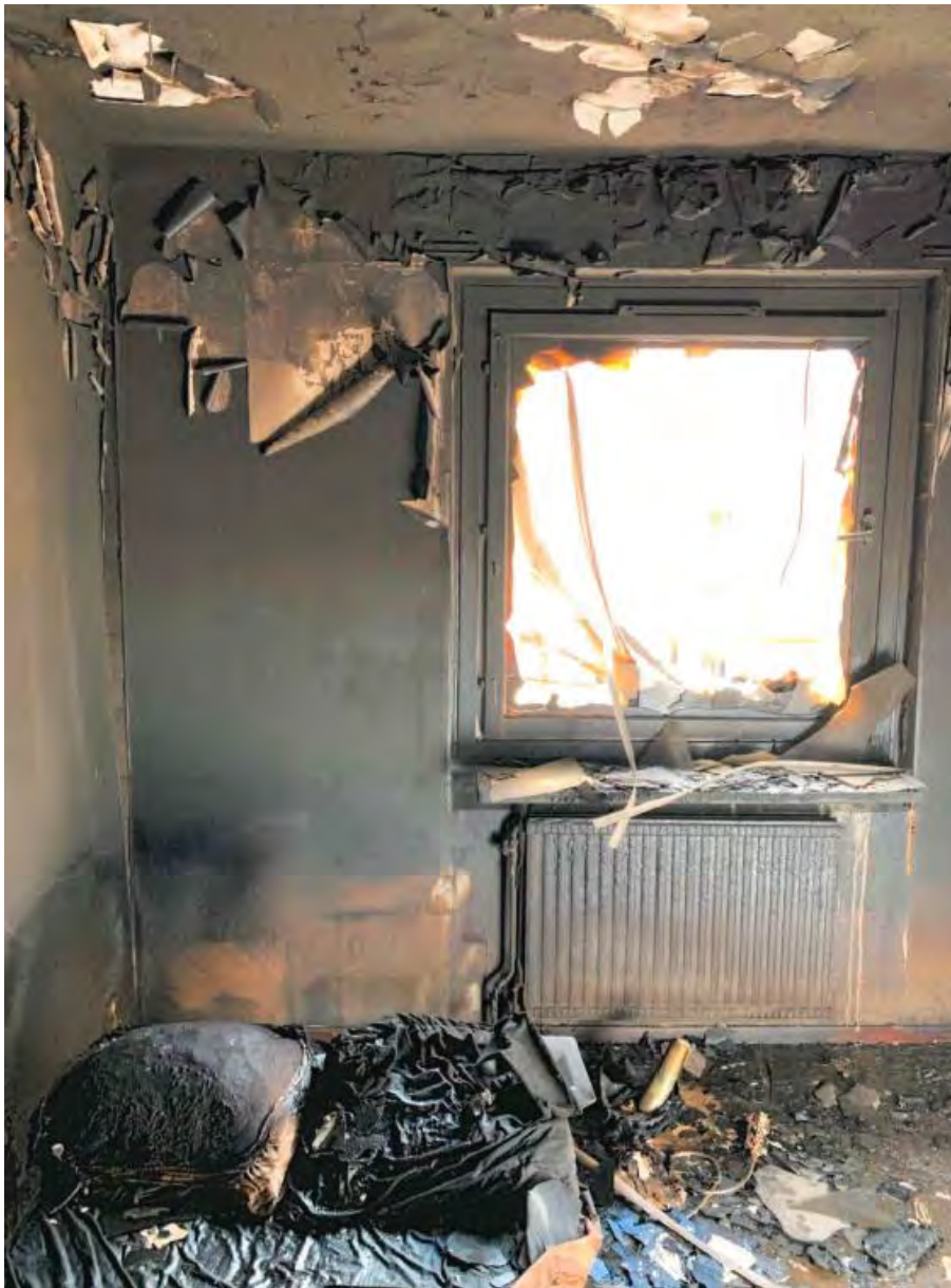
Figur 22. Bild på brandskador i sovrum/vardagsrum (rum C) där personerna vistades när branden bröts ut. De tog sig ut på balkongen via fönstret.
