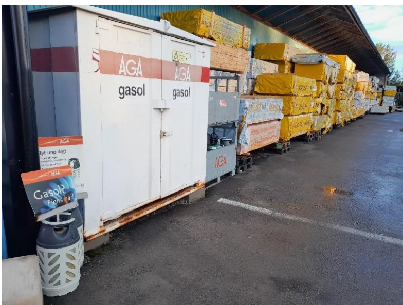
Figur 8 Placering av gasolskåp under skärmtak, foto taget 2023-05-30 kl. 04:55.
