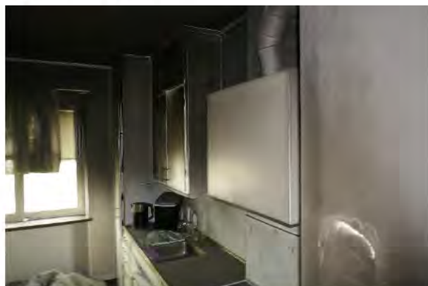
Figur 8 sotskador i köket
