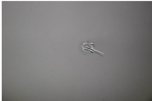
Figur 4 troligen smält brandvarnarfäste
