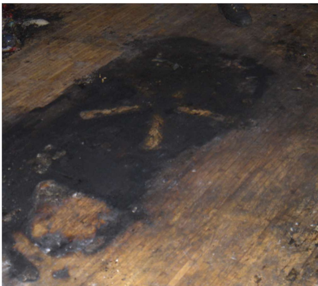
Bild 2 Brandmönster i golvet (efter finröjning)
