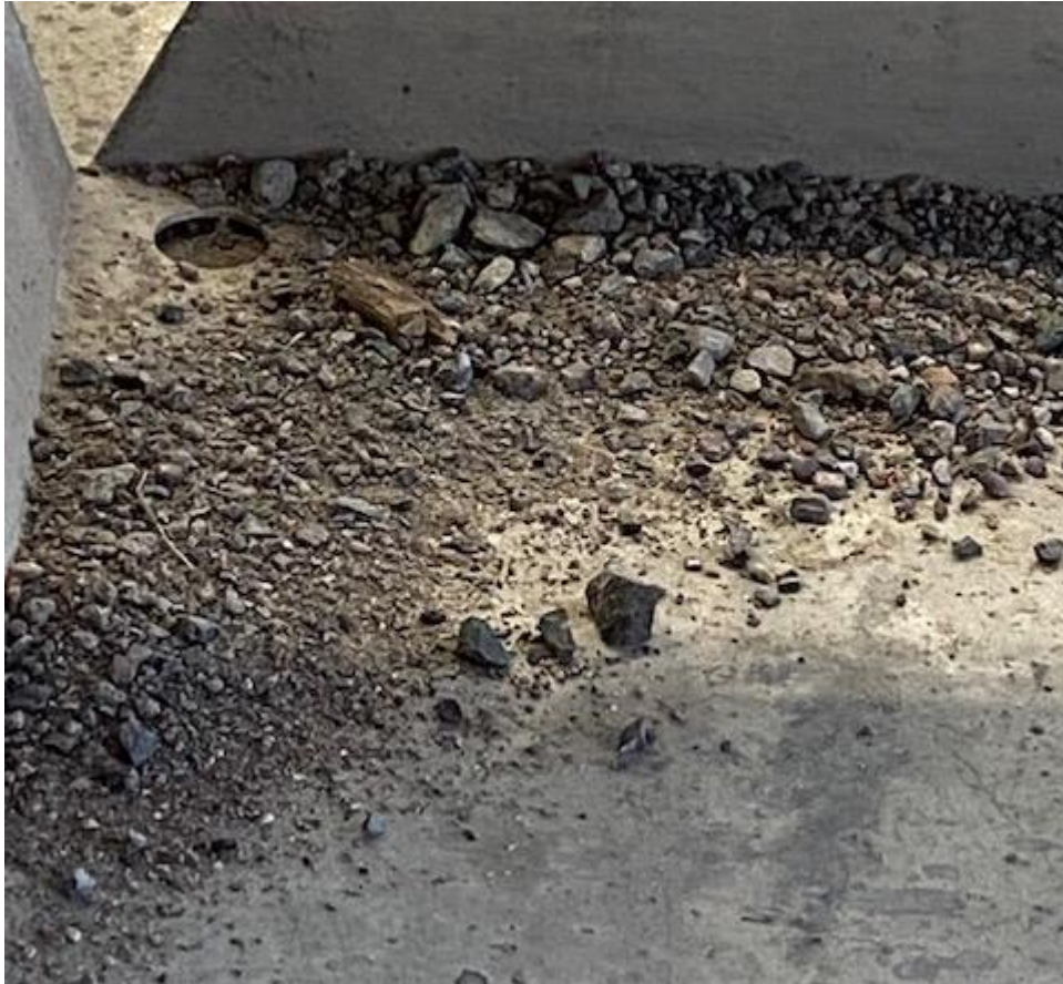
Bild 18 Ansamling av stenar/grus i skyddsplåt efter ca 1 år
