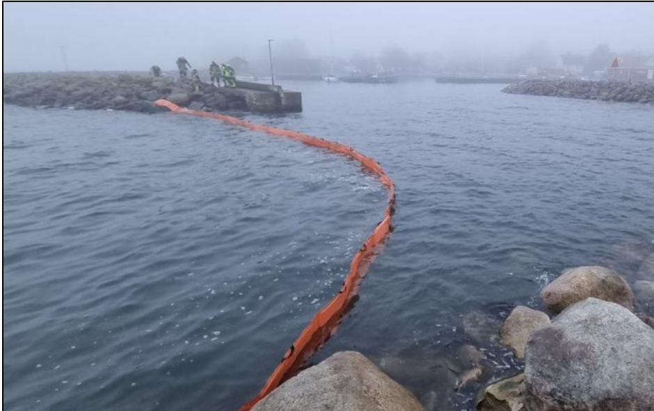
Bild 2: Arbete med att stänga Krokås hamn
