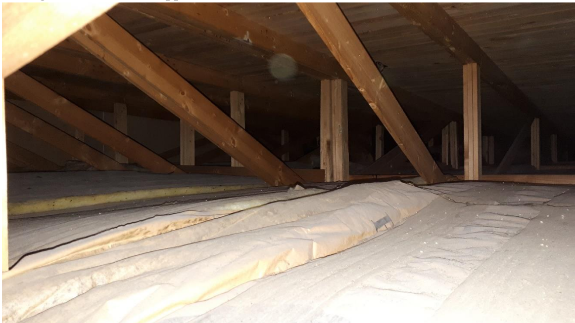
Figur 13 bild på vind från grannhuset med avskiljning
