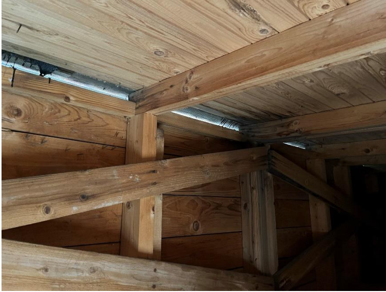
Figur 16 Bild på den öppna ventilerade takkonstruktion med luftspalt upp till. Bild tagen på platsbesök i grannhus.
