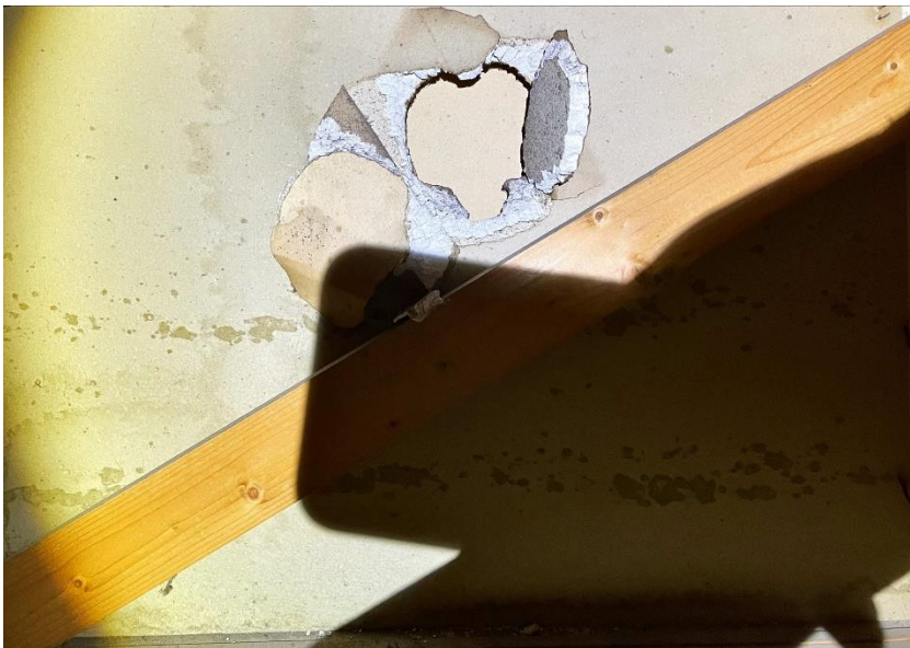
Figur 15 Avskiljning mellan lägenheternas takkonstruktion. Bilden var en tidigare håltagning av den boende.
