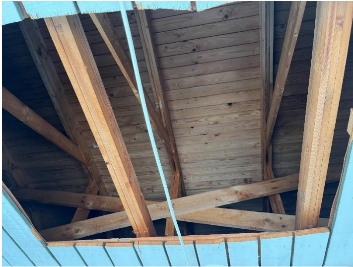
Figur 17 Bild på bjälklag mellan balkong och takkonstruktion i grannhus.
