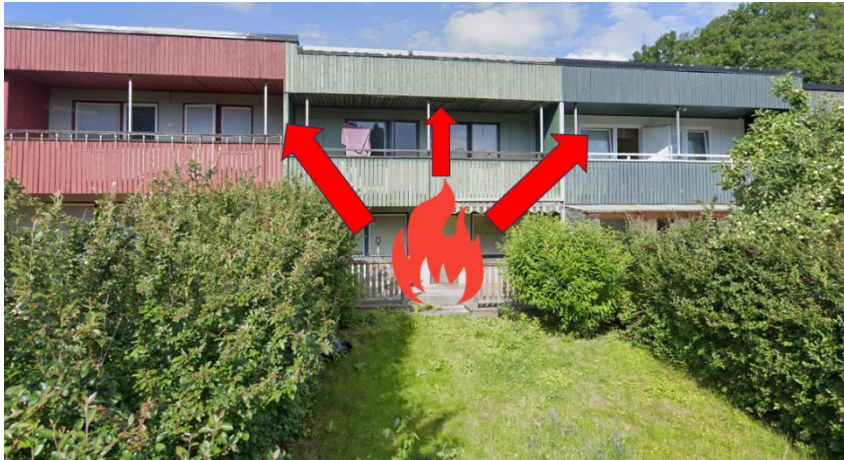
Figur 20 Visualisering om trolig brandspridning på baksidan. Foto från grannbyggnad.
