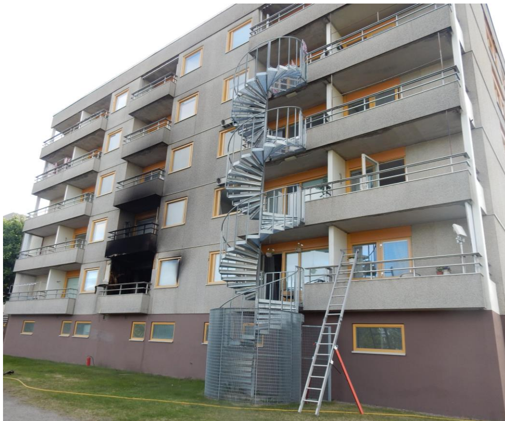
Bild 2. Fasad med brandlägenhet och spiraltrappa som användes för utrymning av personer. En person utrymdes via stegen från balkongen med hjälp av ambulanspersonal.
