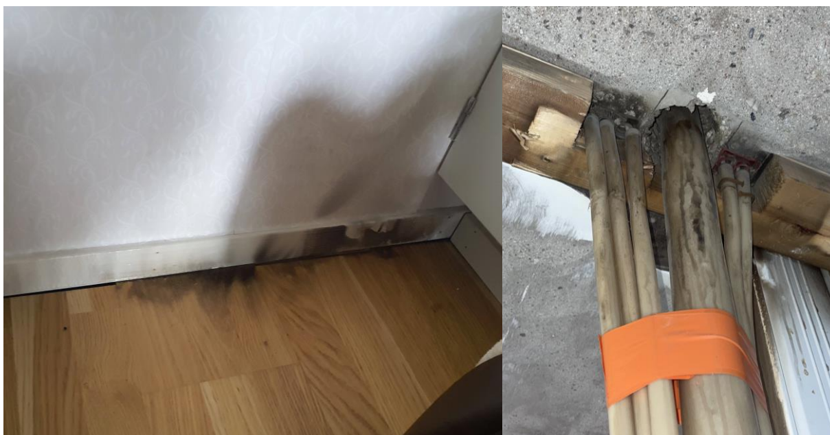
Bild 5. Rökskador och spridningsställe i lägenheten ovanför brandlägenheten. I lägenheten stod den boendes säng ställd intill denna vägg. Den högra bilden visar genomföringen sett från brandlägenheten.
