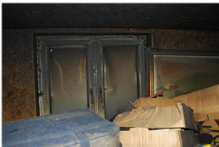
Figur 8, Sprickor i innerglaset, indikerar att temperaturen varit ca 300-400 grader.
