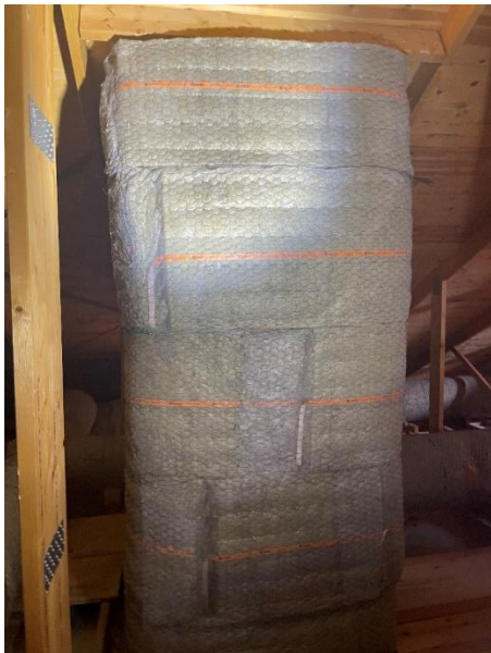
Figur 33. Schakt för rökluckan till trapphuset. Schaktet är försett med brandisolering och är monterad i takkonstruktion i brandteknisk klass R0.
