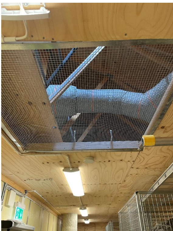
Figur 2. Bild tagen i grannhuset i förrådsdelen upp mot installationsutrymmet.
