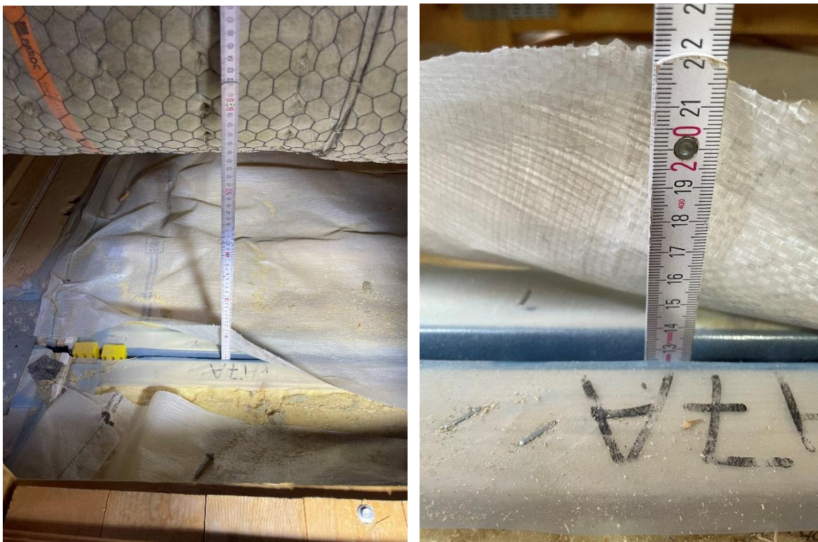
Figur 32. Bjälklaget mellan trapphus och vind, bilderna tagna ovanifrån. Träreglarna utgörs av 120*45 mm och är exponerade mot vinden.
