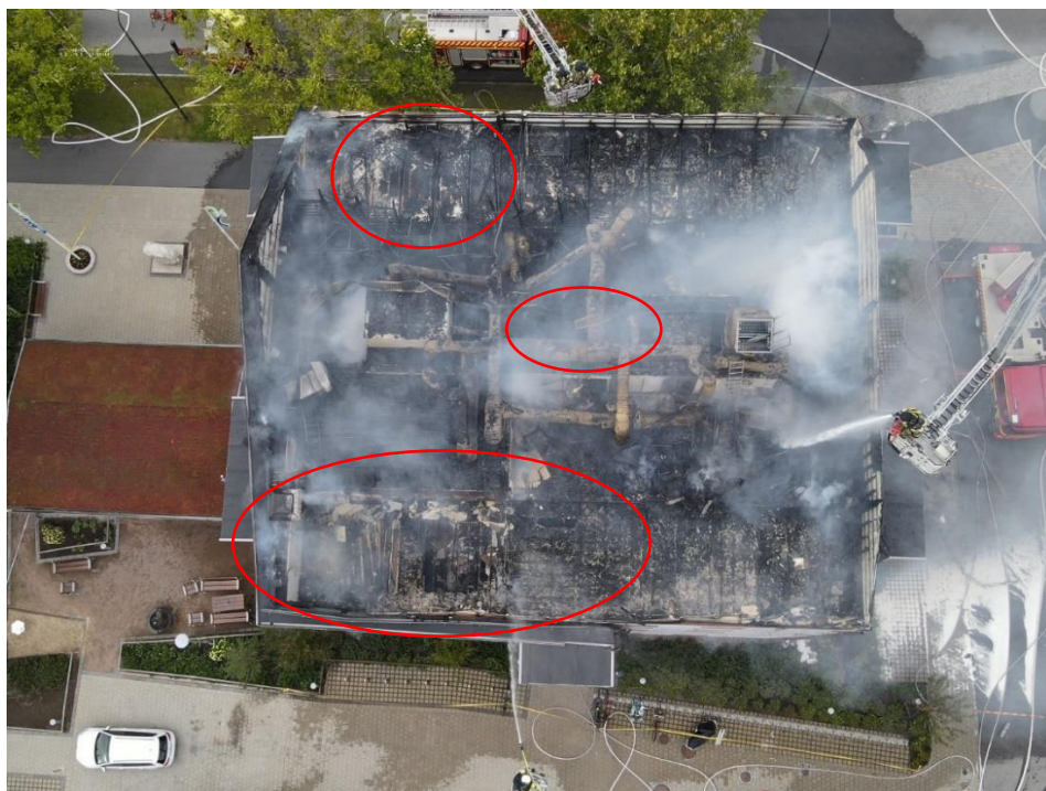
Figur 13. Skadorna rakt ovanifrån. Där bjälklaget delvis rasat in är inringat.
