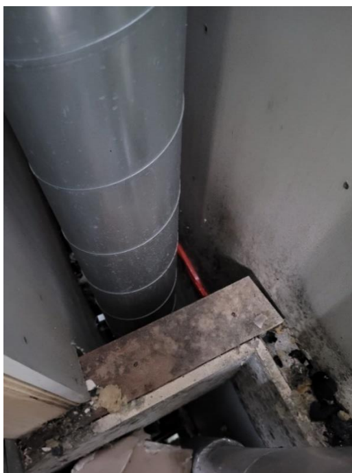
Figur 29. Installationsschakt i byggnaden i gips.
