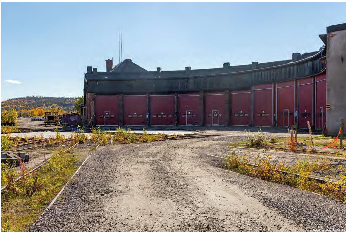
Bild 7. Lokstallet, vy från norr, före branden. (Trafikverket)
