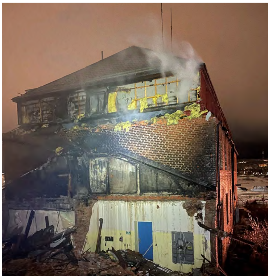
Bild 14. Foto från kl. 03:34 av brandväggen mot lokstationen efter rivning av lågdelen.
