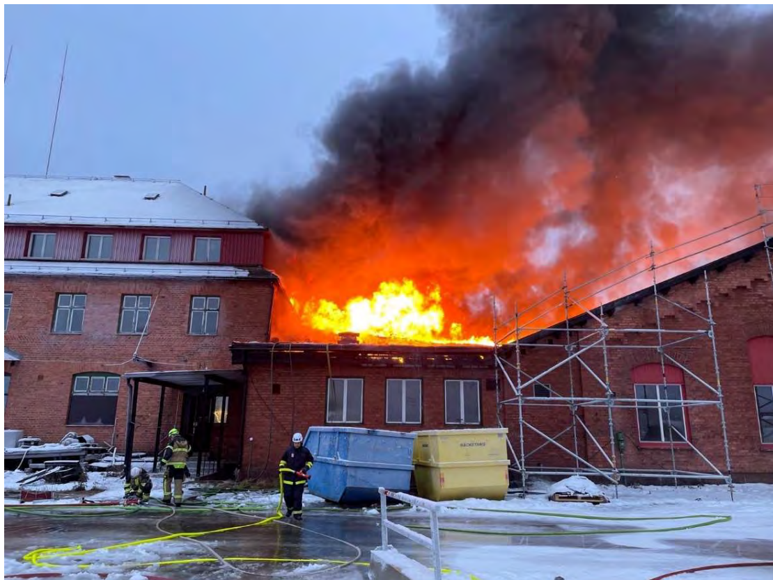
Bild 12. Foto (okänd tidpunkt) på brandspridning över begränsningslinjen sektor kontor/tak.
