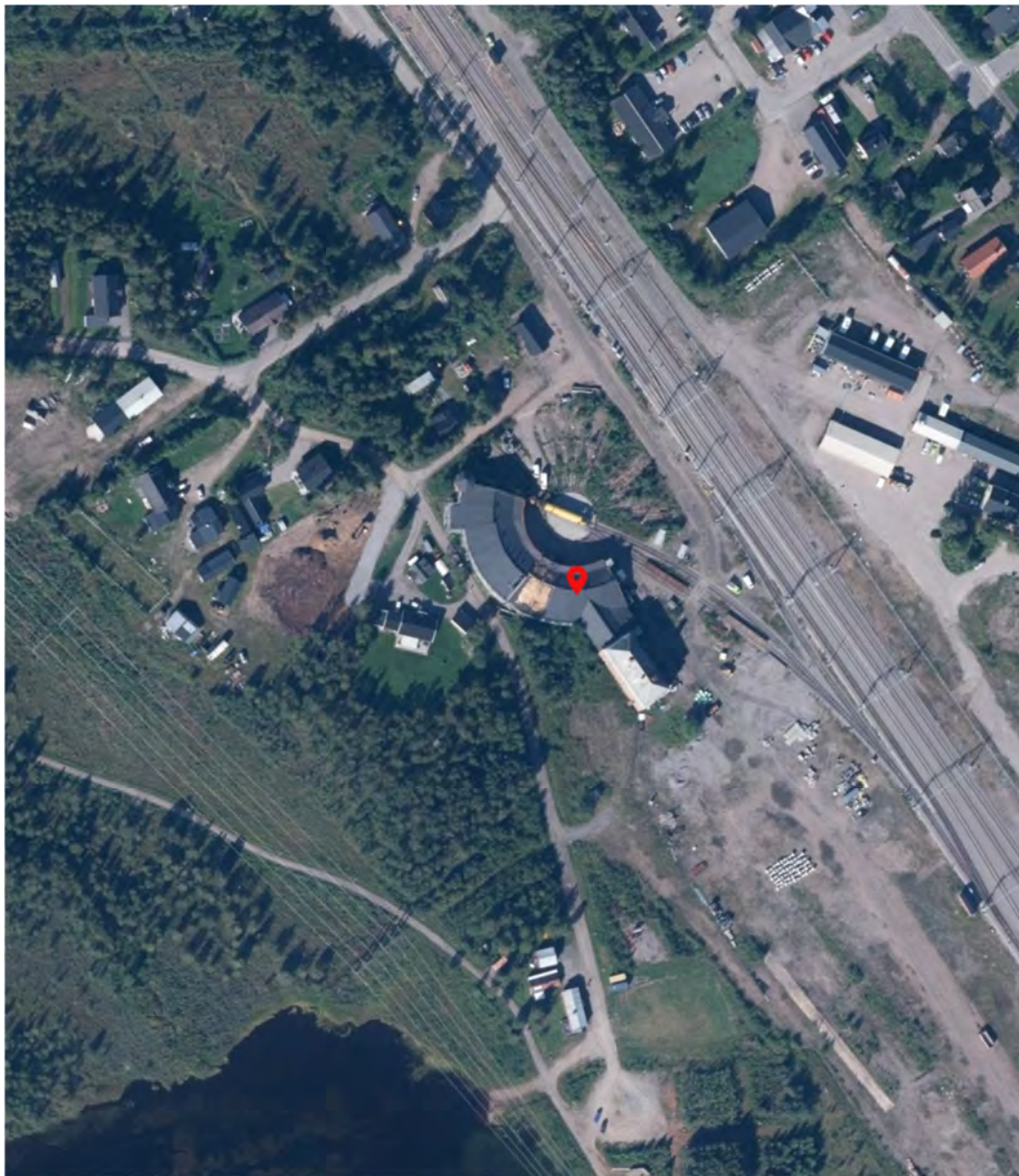
Bild 3. Flygfoto som visar lokstall, lokstationsbyggnaden och dess omgivning.
