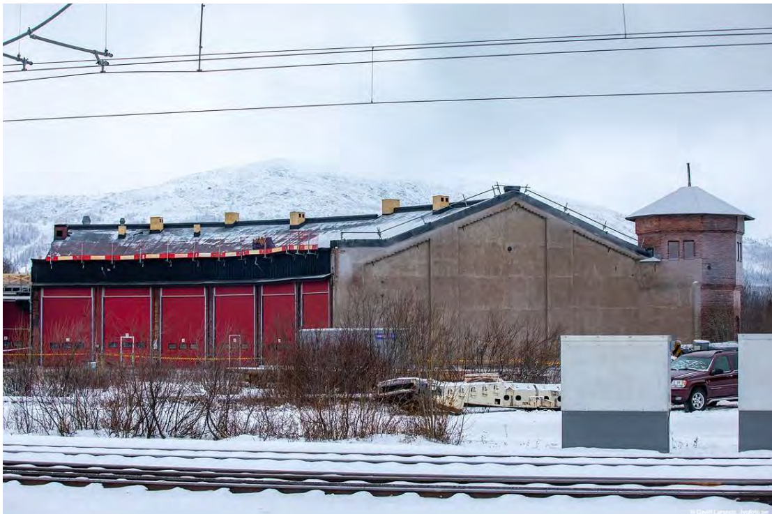
Bild 15. Foton på förmiddagen efter branden. Södra lokstallet och lågdelen i ruiner, lokstationen kraftigt brandskadad, men "verkstaden" i norra delen av lokstallet räddades.
