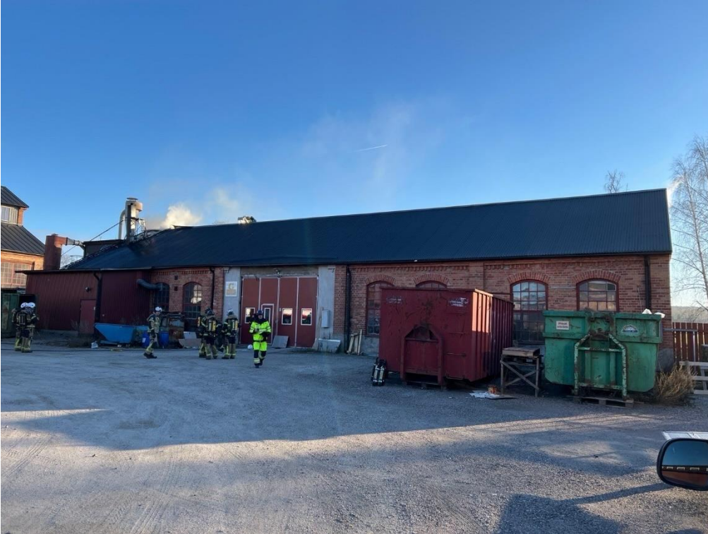
Industribyggnad, foto från gården kl. 11:41 (foto: Räddningstjänsten)
