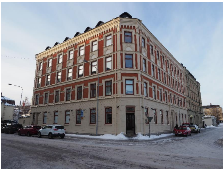
Bild 2 Visar husets framsida
