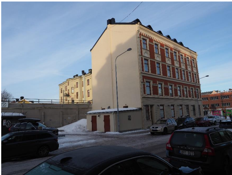
Bild 1 Visar delar av baksidan och hur huset är byggt i vinkel
