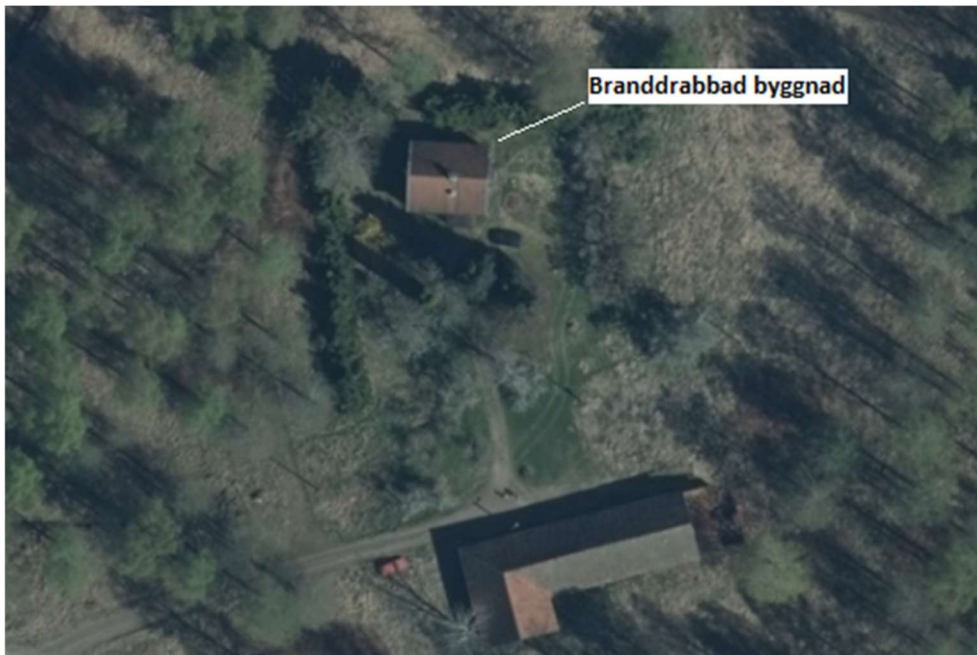
Figur1. Satellitbild från Lantmäteriet över fastigheten, med den branddrabbade byggnaden markerad.
