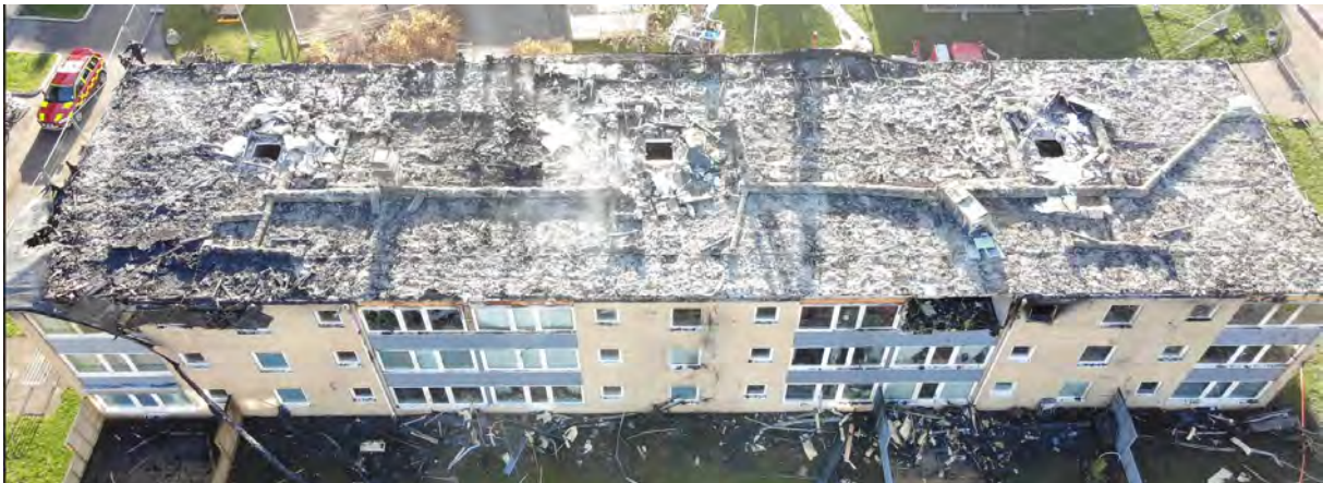
Figur 24 - Drönbild polisen 2022-11-09 som visar taket och baksidan. Adress ■ C till höger i bild. Endast en mindre del av takkonstruktion återstår (längst ner t.v. i bild).
