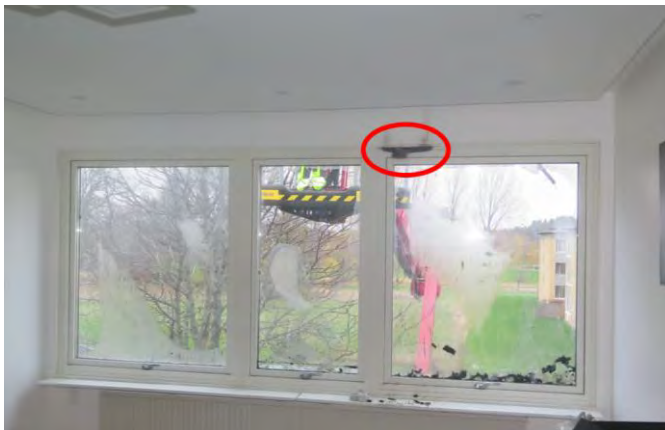
Figur 30 - Foton från platsbesök 2022-11-11 som visar lgh 1201 (mittenmot den branddrabbade på samma plan). Överlag har lägenheten klarat sig bra, dock noteras mindre genombränning i ovkant av vardagsrumsfönster. Se röd markering. I hallen påträffas en brandvarnare på byrå/hylla med batteri urtaget (kan antas ha plockats ned av räddningstjänsten).
