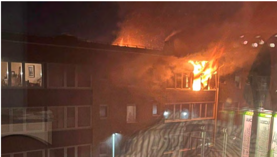
Figur 13 - Baksidan. Foto taget av vittne klockan 23:51. Observera lågor/gnistregn även på andra sidan taket. Rök kommer även ur frånluftshuv. Röken går norrut.
