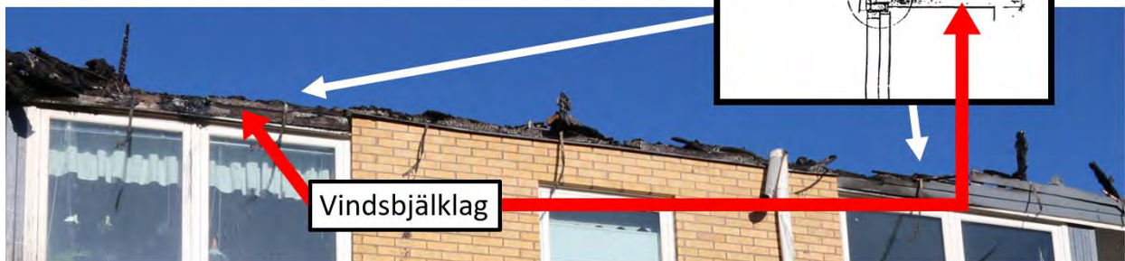
Figur 8 - Exempelbild konstruktion framsida. Närbild (foto från polisen) visar del av lgh 1201 och 1202 adress ■ A. Referensfoto kommer från Googlemaps-Streetview och visar motsvarande del på annan likvärdig byggnad inom området. Även klipp från konstruktionsritning (1971) över väggsektion vid köksfönster visas.
