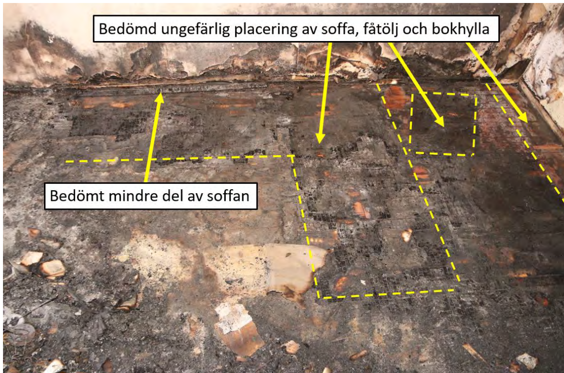
Figur 29 - Foto taget av polisen vid gemensam undersökning 2022-11-18 efter att golvytan i vardagsrummet frilagts. Tillagda markeringar i foto visar bedömd ungefärlig placering av soffa, fåtölj och bokhylla baserat på tidigare dokumentation (efter Brand 1) samt brandmönster i golv.
