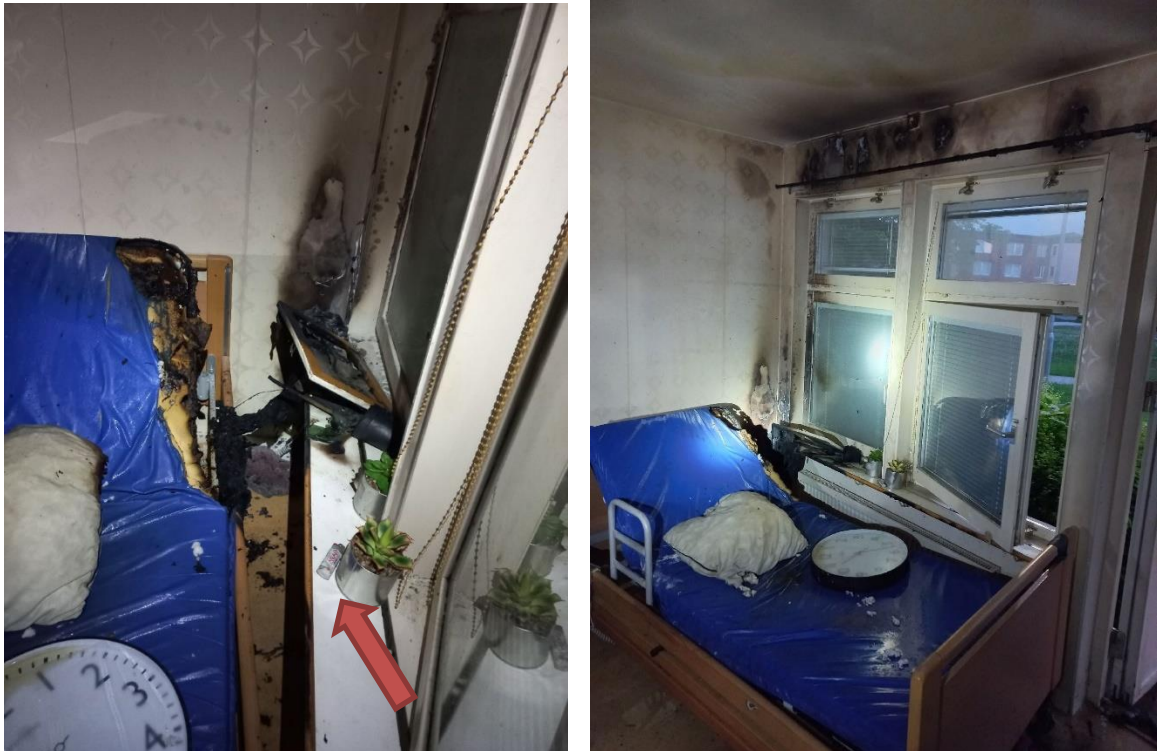
Figur 2. Till vänster: Brandskador på vägg och madrass. Pil visar på tändare intill sängen. Till höger: Brandskador runt fönster indikerar var gardin har brunnit.
