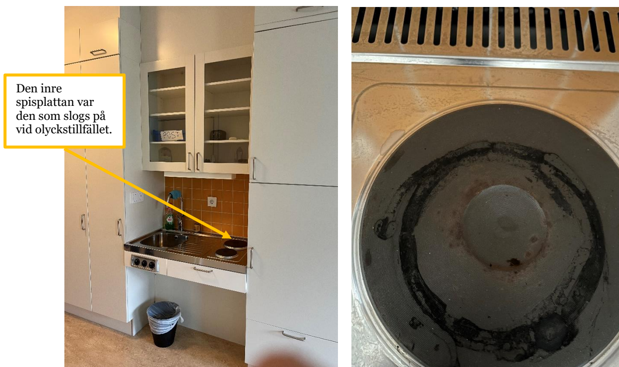
Figur 2 och 3. Bild på trinettök i lägenhet inom verksamheten. Märken efter bränd plast synliga på spispatta.
