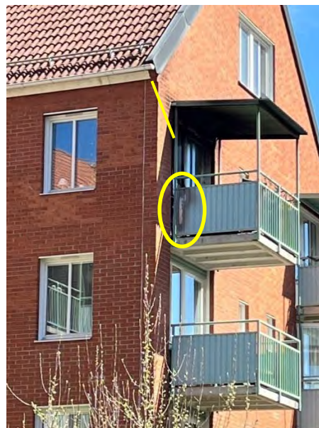
Figur 2 och 3. Brandpåverkad balkong, Spår av brandrök på fasad synlig på sidorna av skärmtak samt värmepåverkan av balkongens utsida markerade
