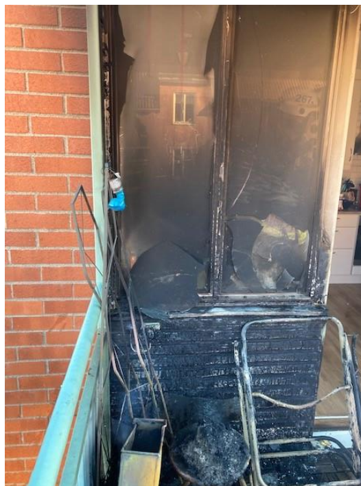
Figur 4 och 5. Brandpåverkad balkong från utsidan samt initialbrandsområde på balkongens insida.
