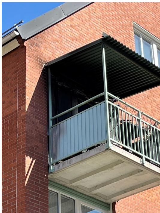
Figur 4 och 5. Brandpåverkad balkong från utsidan samt initialbrandsområde på balkongens insida.
