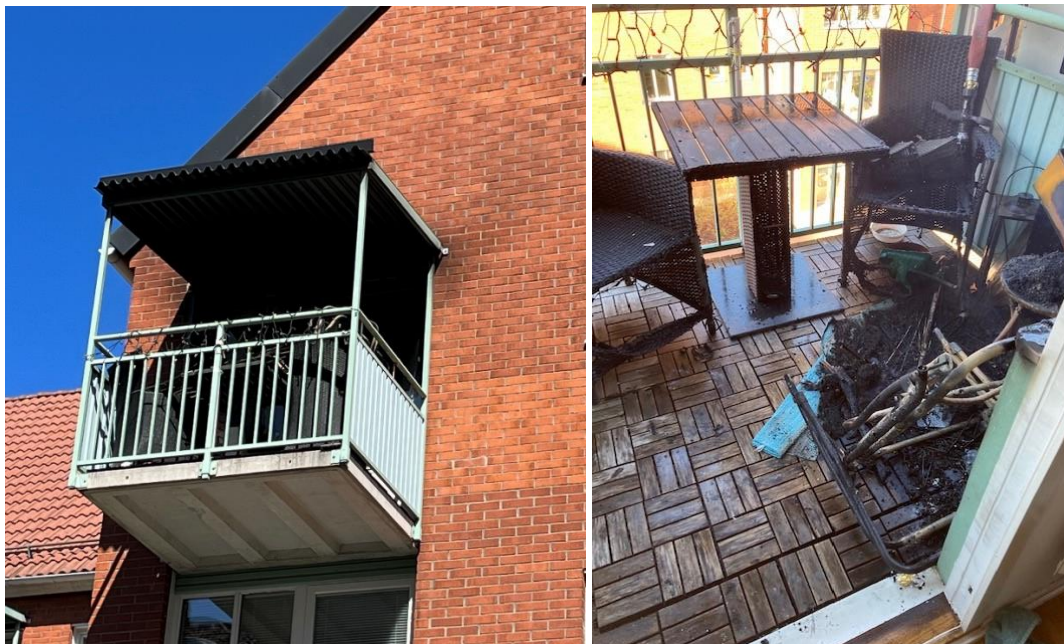
Figur 7 och 8. Brandbalkongens utsida samt bild från lägenheten ut mot balkongen. Synliga brandskador på möblemanget från initialbrandsområdet till höger i figur 8.
