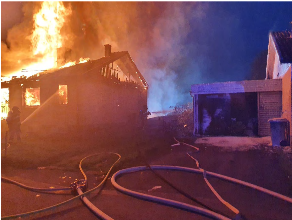
Bild 1: Delar av taket har rasat in och gavelspetsen har det brunnit igenom. Fullt utvecklade brand inne i byggnadens södra del.
