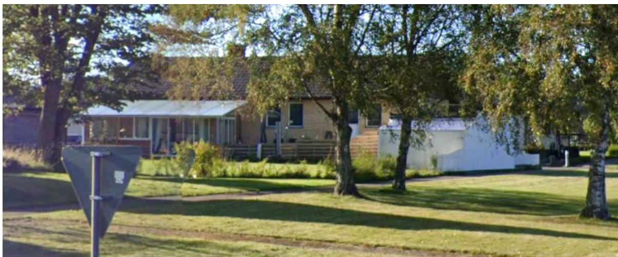
Bild 1: Byggnaders baksida med uteplats. Foto Street View Google.
