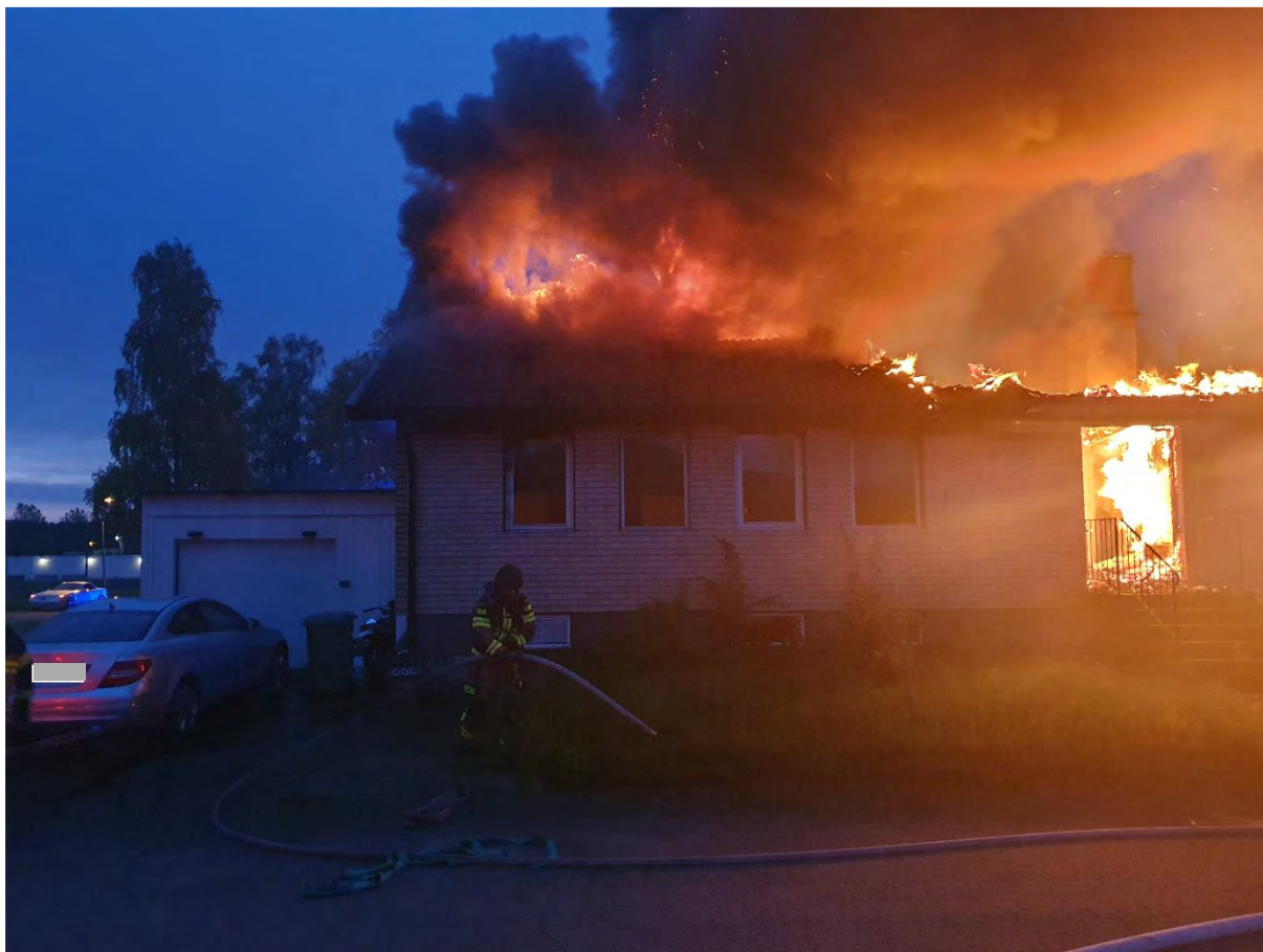
Bild 2: Branden sprider sig till hela taket. Branden har ännu inte utvecklats i byggnadens norra del där bland annat sovrum finns.
