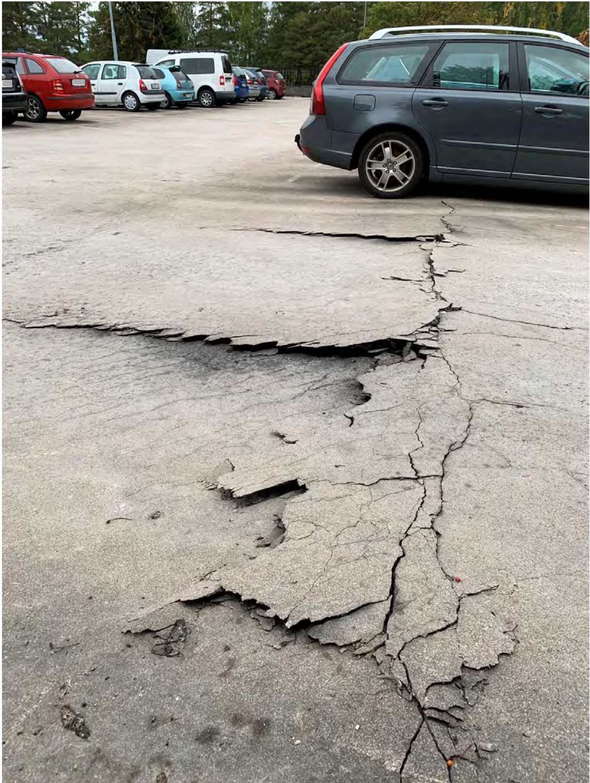
Bild 5. Sprickor på det övre våningsplanet.
