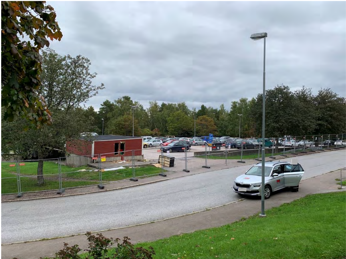
Bild 2. Vy över det tillbyggda soprummet samt parkeringshusets övre del.
