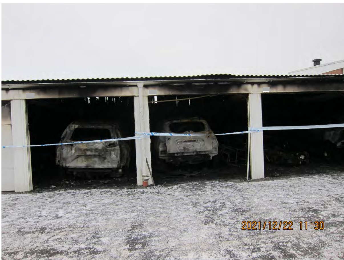
Bild 6: Plats är en trolig primär brandstartsplats.
