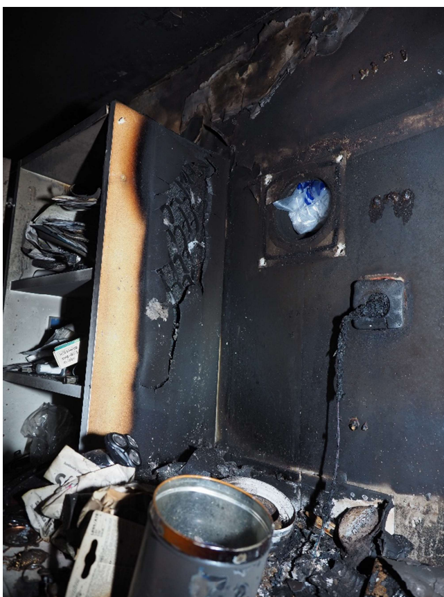
Bild 12: Rakt ovanför spisen syns dels kontakten till köksfläkten och dels en tydlig oskadad del av skåpet där kryddhyllan suttit. Av bilden framgår också att branden varit kraftig bakom kryddhyllan med tanke på brandskadorna på sidan av skåpstommen bakom där kryddhyllan varit monterad.
