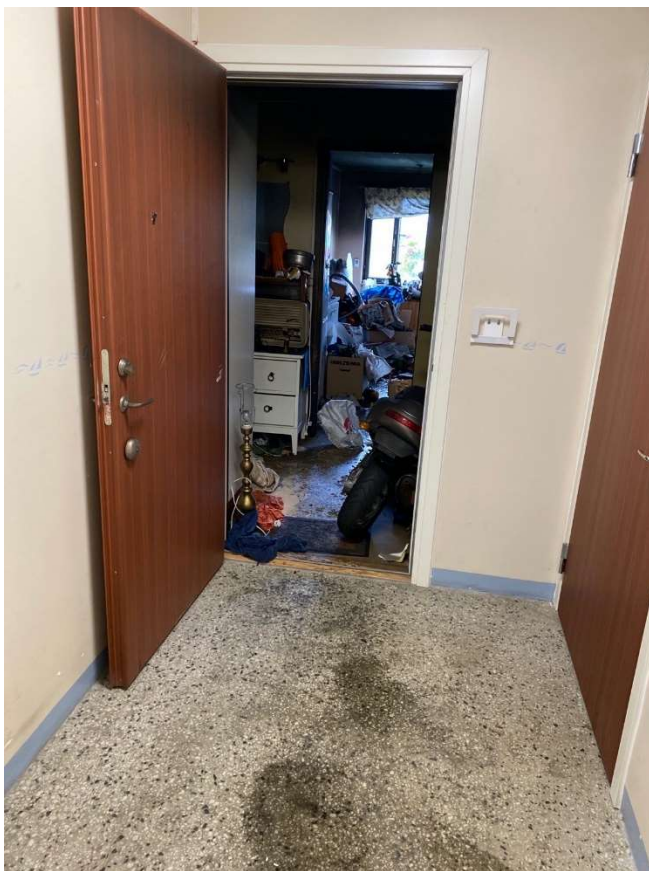
Bild 3: Lägenhetsdörren har klass EI 30. Innanför dörren syns lägenhetsinnehavarens moped parkerad. I lägenheten finns mycket brännbart material.
