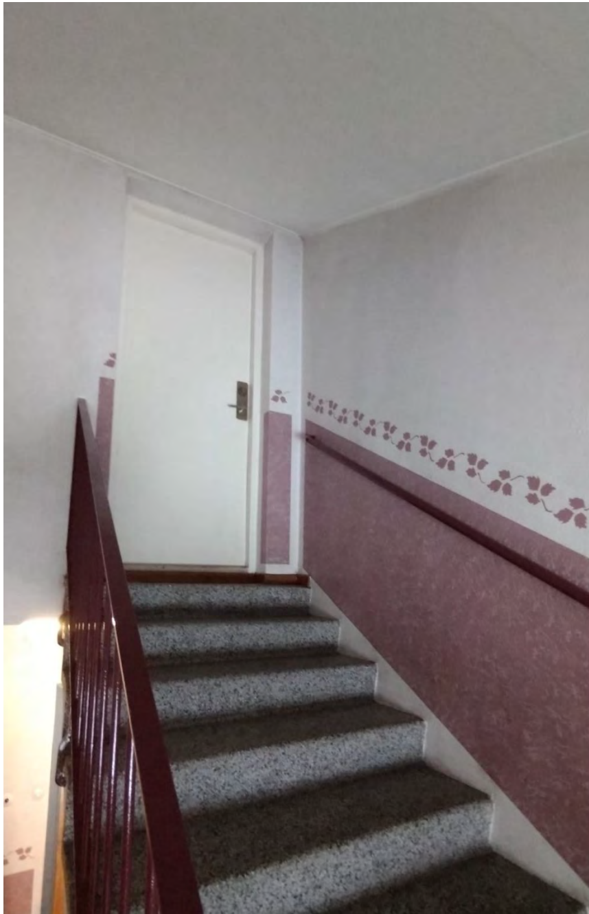
Dörr från trapphuset in till vinden, ett plan ovanför brandlägenheten.
