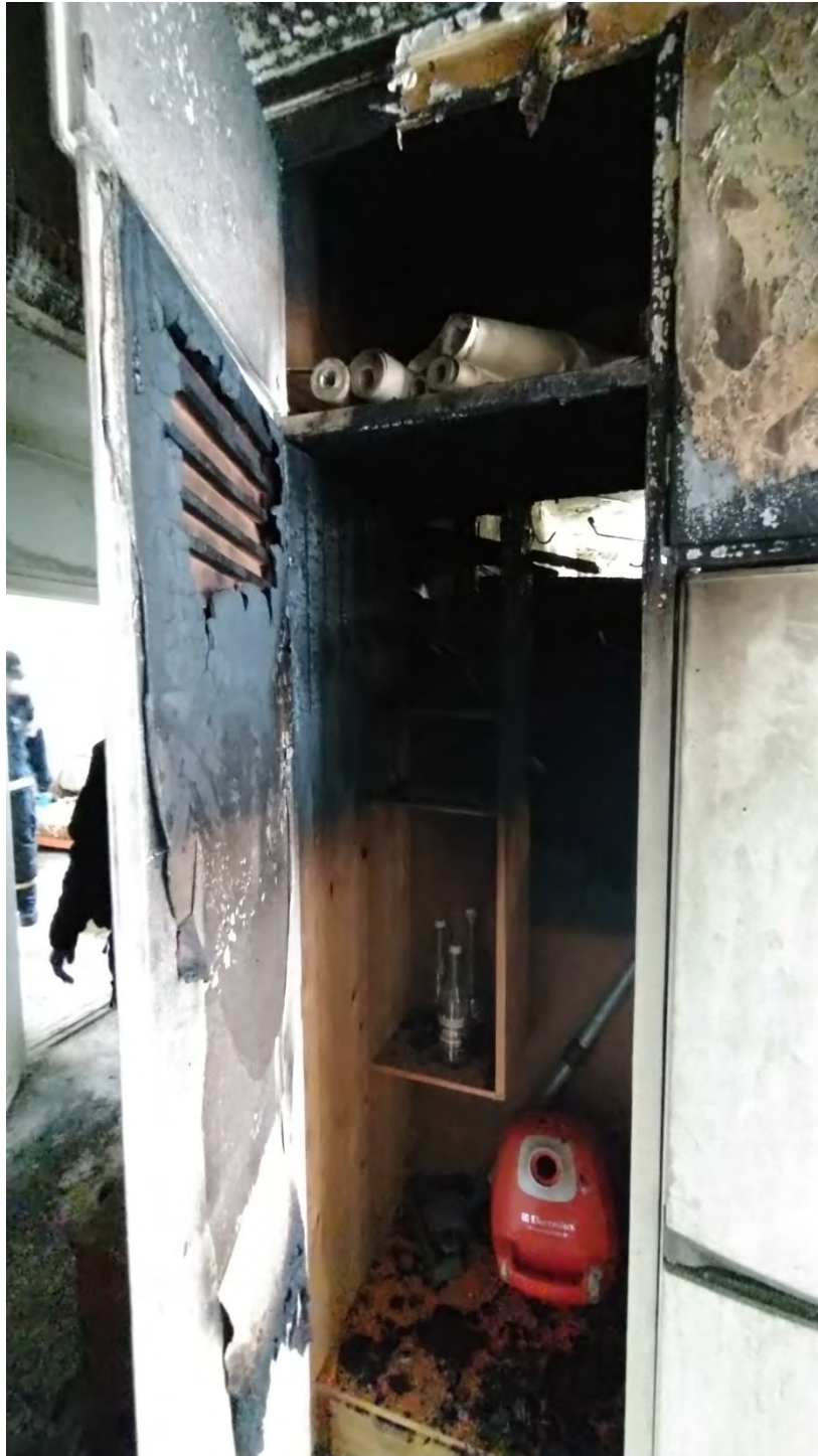
Brandspridning ut till kök via köksskrubb.
