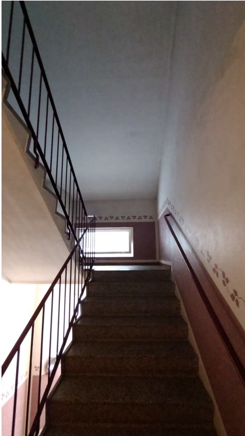
Trappa upp mot vinden
