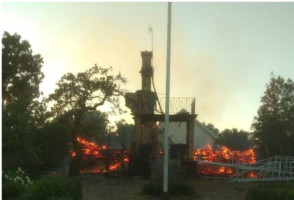
Figur 5 Bild tagen 21:40. Hela byggnaden är nedbrunnen
