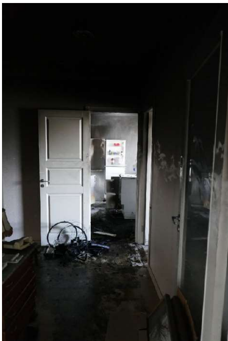
Figur 3. Bild tagen i hallen i riktning mot köket.
