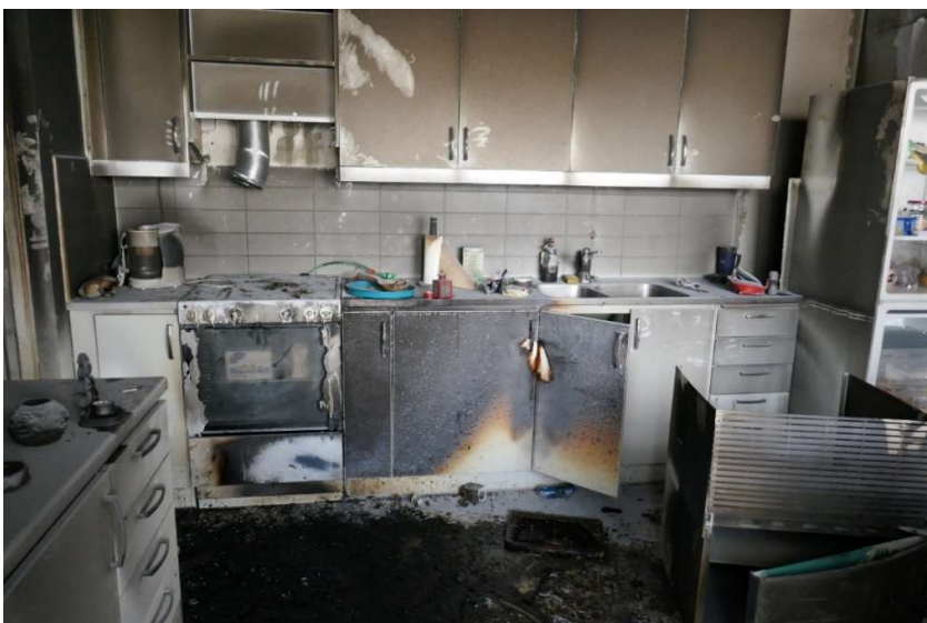
Figur 4. Brandskador koncentrerade till området framför och till höger om spisen.
