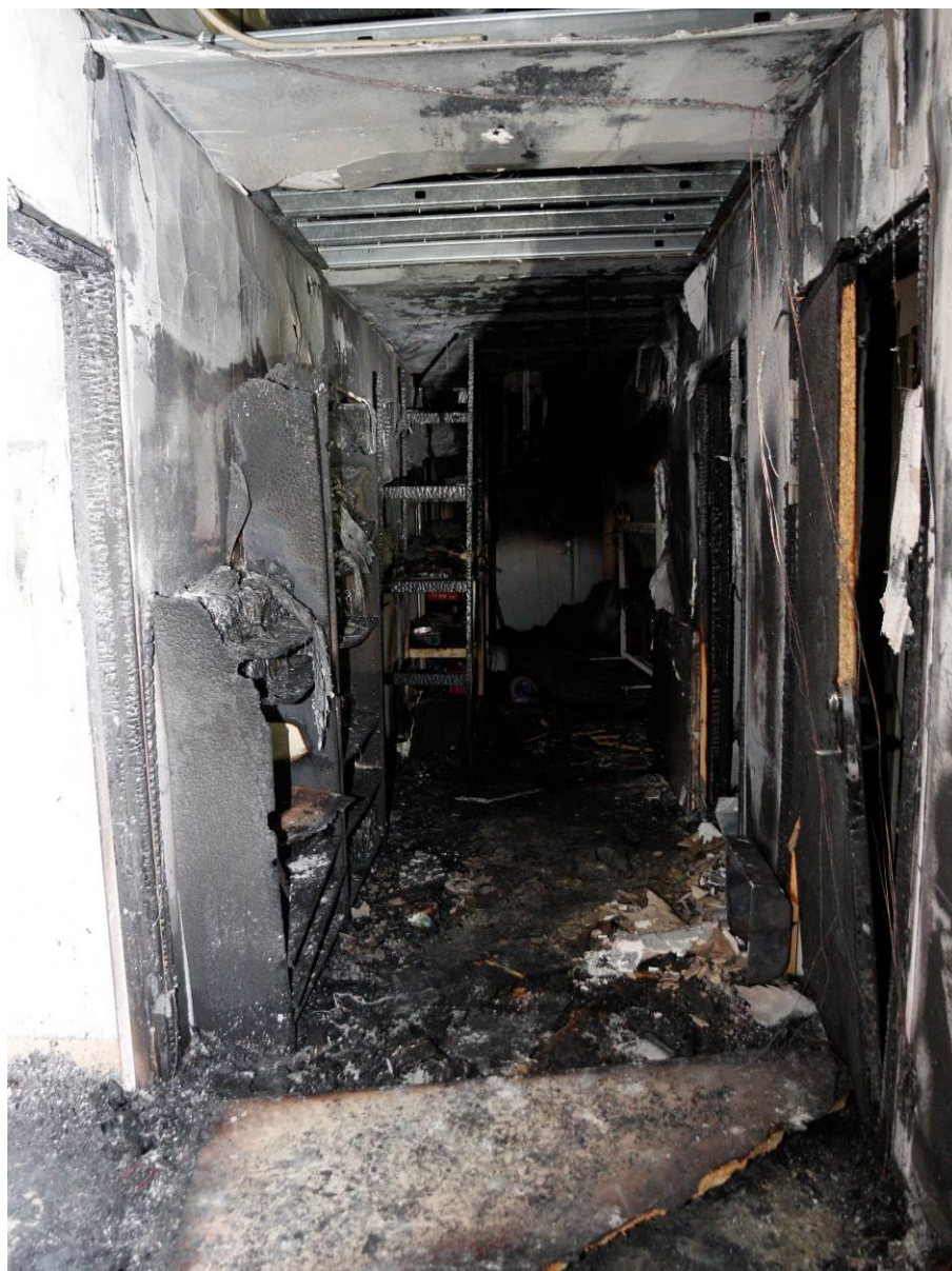
Brand i korridor utanför tvättstuga
