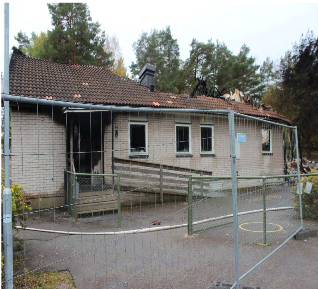
Bild 10 Byggnadens norra sida. Den östra entrén syns rakt fram.
