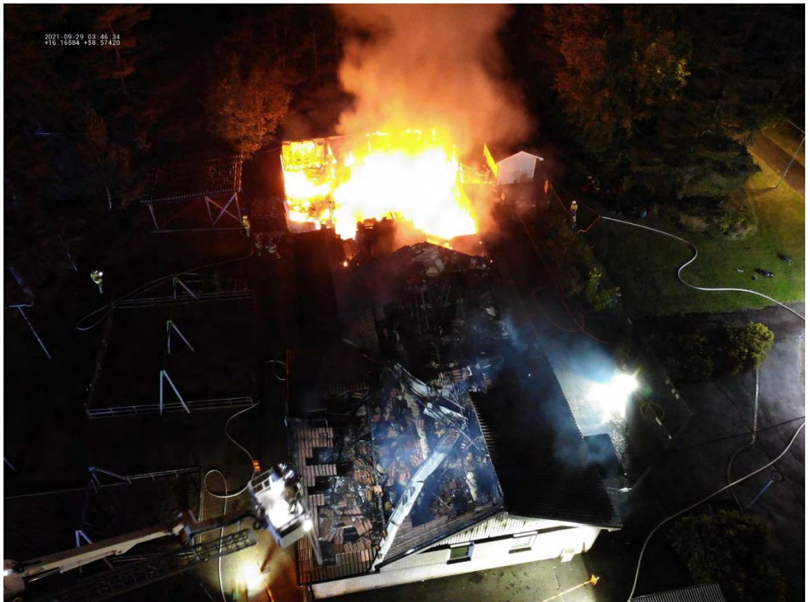
Bild 9 Västra delen brinner helt och hållet och målet med insatsen blir att säkra östra delen av byggnaden för polisens undersökning.
