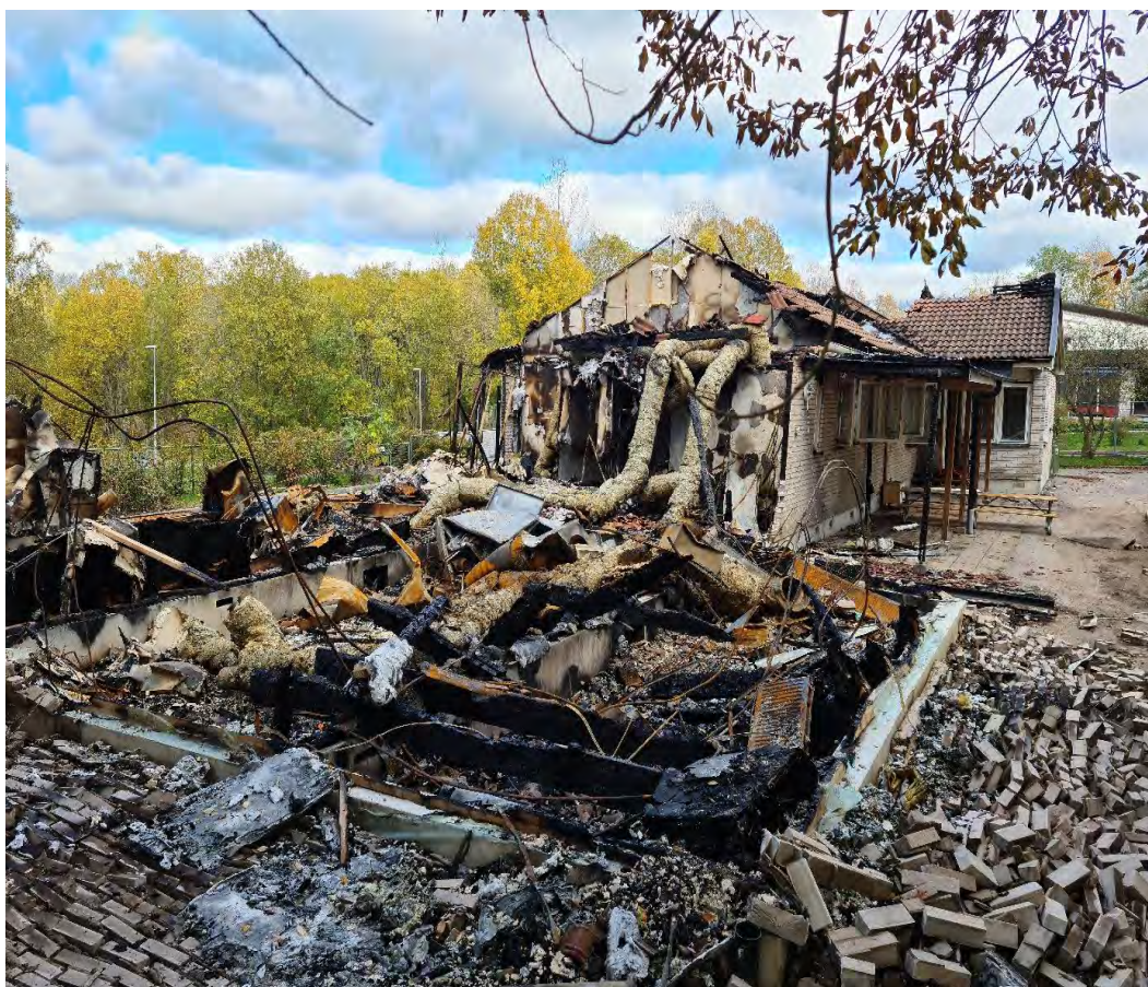
Bild 11 Byggnadens västra del som totalförstördes.
