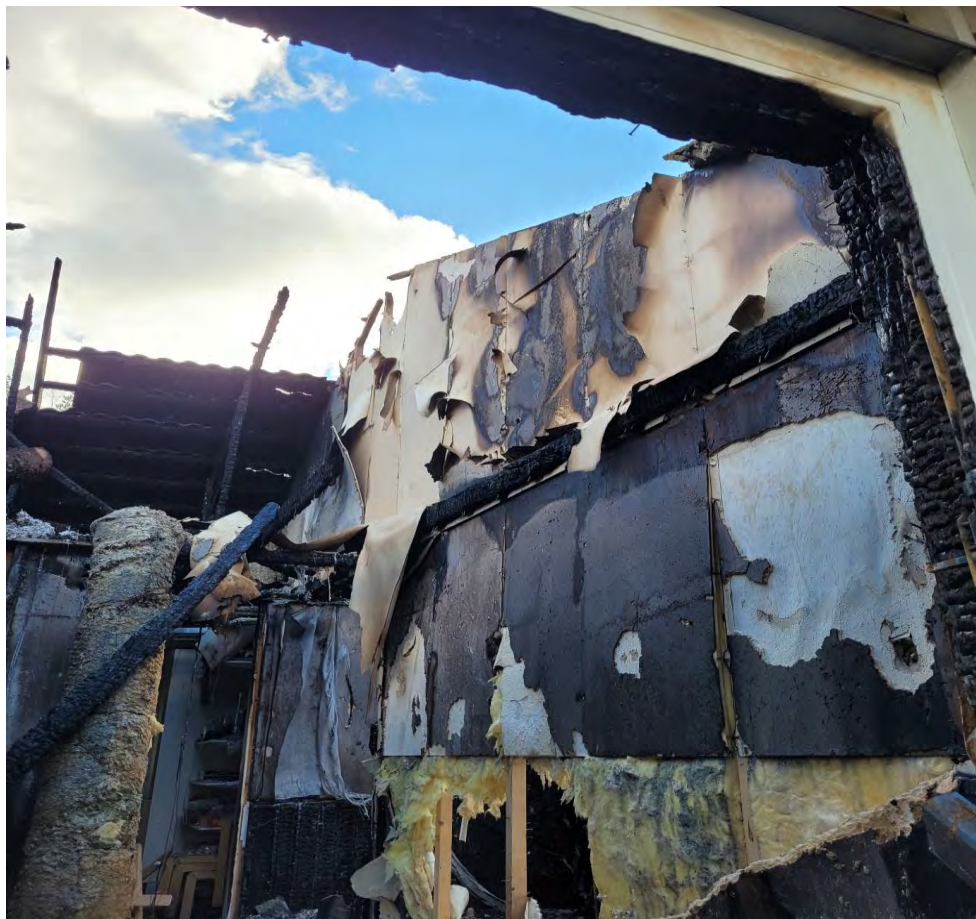
Bild 7 Väggen i mitten av byggnaden som gick upp genom vindsutrymmet till yttertaget.
