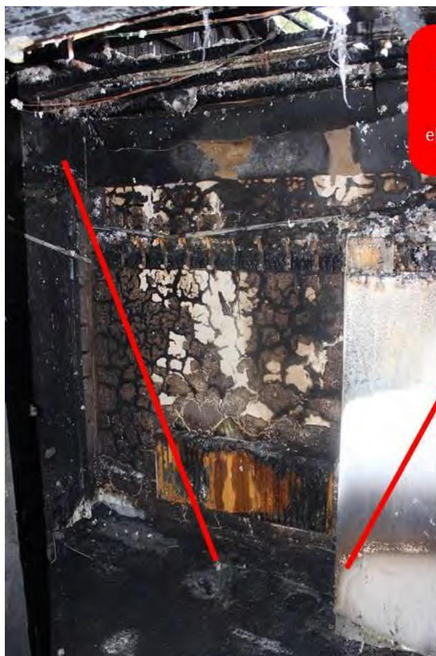
Bild 4 På väggen ovanför element i hallen syns ett lågt brandmönster (V-format) som visar på att detta varit primärt brandområde.
