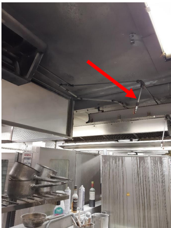
Bild 1. Pilen visar felriktat munstycke.
