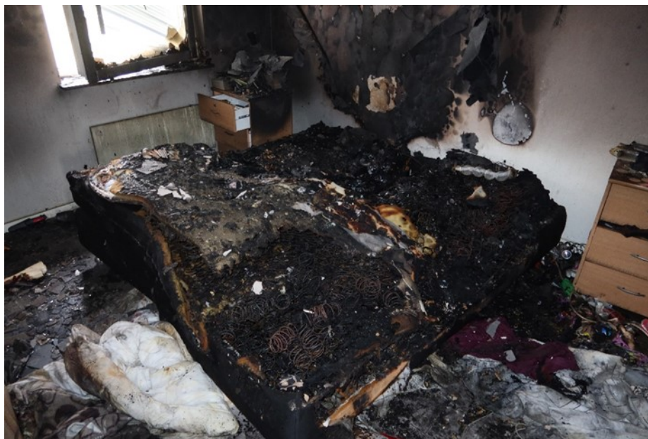
Figur 3. Sovrummet på andra våningen där den avlidna personen påträffades. Brandskador i säng och på väggar.
