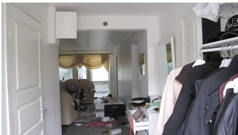
Figur1. Bottenvåning med hall och vardagsrum. På våningen fanns en monterad brandvarnare som inte fungerade. Hela bottenvåningen rökskadades.
