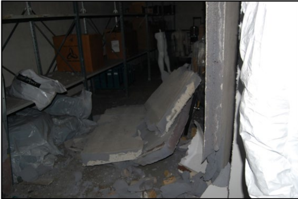
Figur 14 visar delvis raserad vägg. Källa RSG
