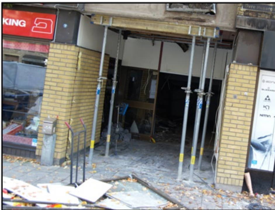
Figur 27 visar entrén med stämp, Källa RSG
