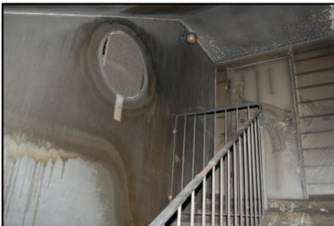
Figur 9 visar rökluckans placering högst upp i trapphus 22. Källa RSG
