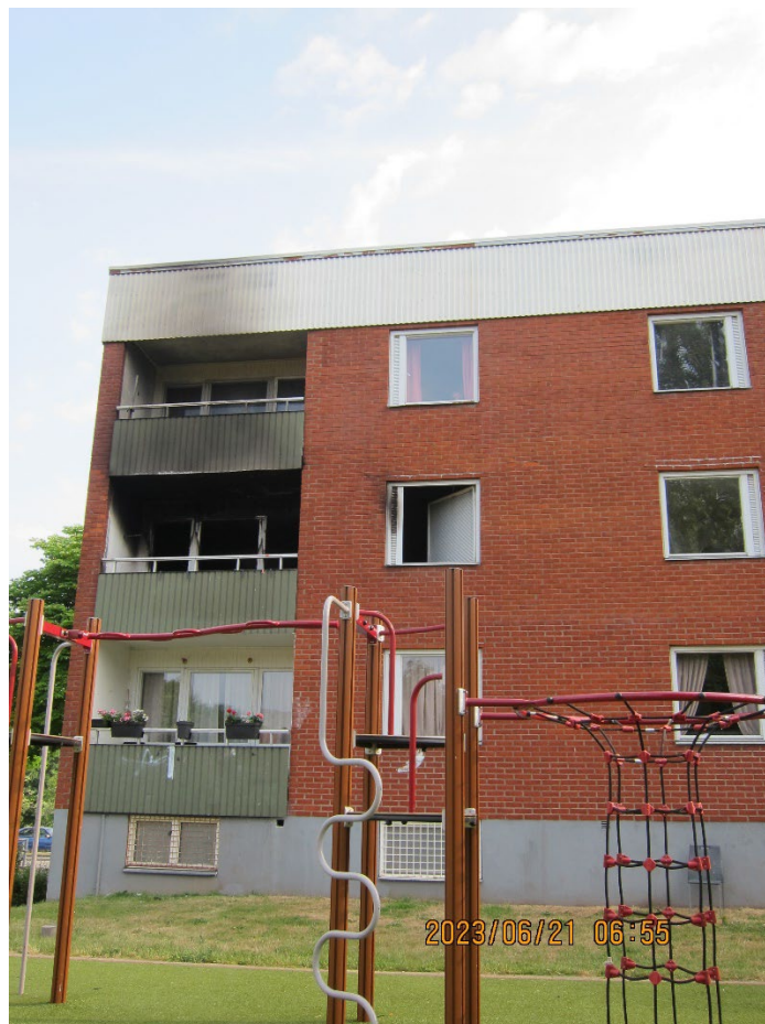
Bild 1. Vy över balkong som ansluter till vardagsrum och fönster till sovrum
