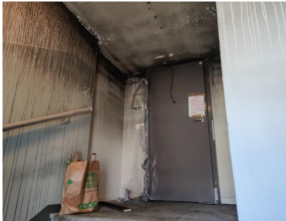
Figur 3. Dörren till vinden från trapphuset på Floravägen.
