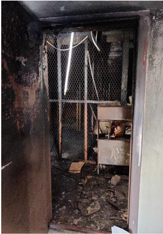
Figur 7. Vy från trapphusets dörr mot vinden.
