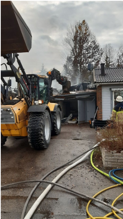
Rivning av garaget
