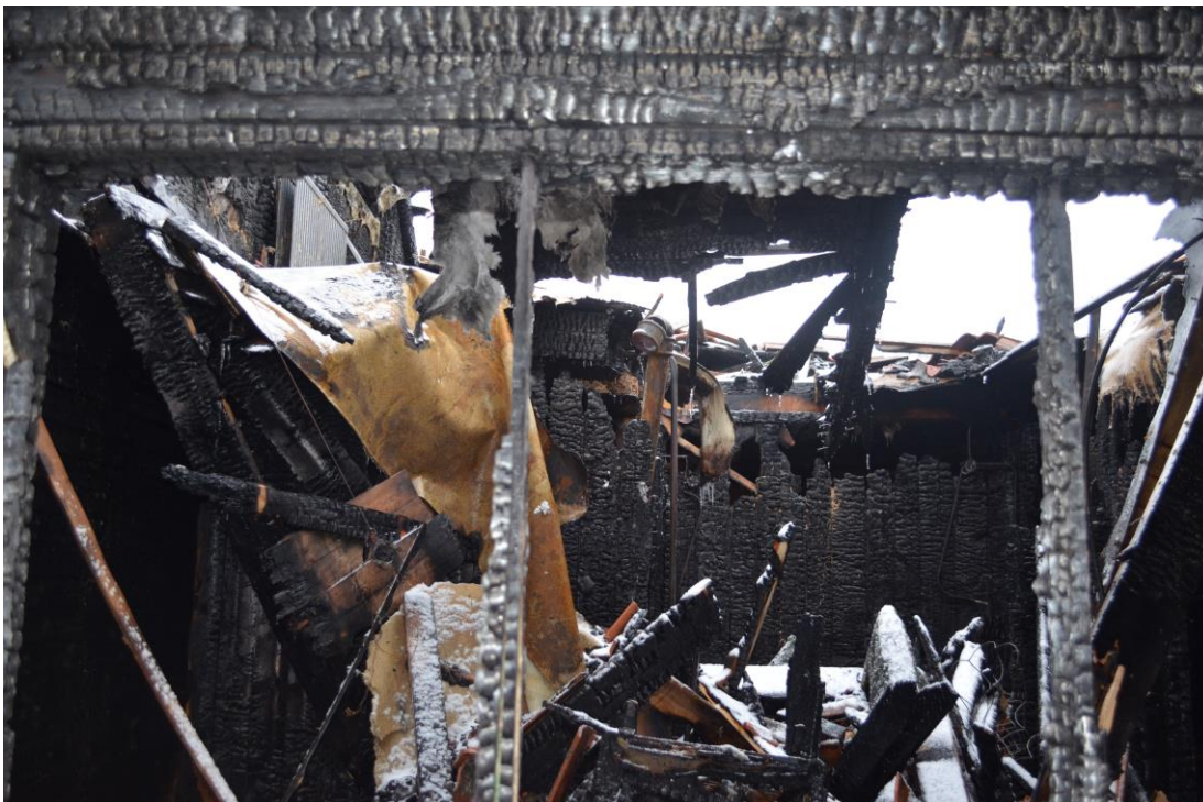
Figur 6: närbild på sovrum med genombränning av tak
