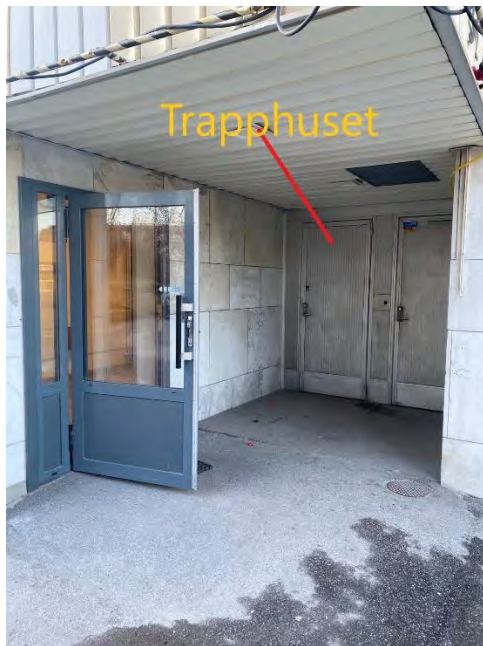
Visar glasdörr till huvudentré samt dörr som leder in till trapphus
