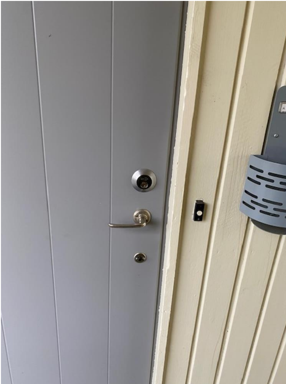
Bild 4. Säkerhetsdörr med regel. Dörren till den drabbade lägenheten var dock hängd åt andra hållet.
