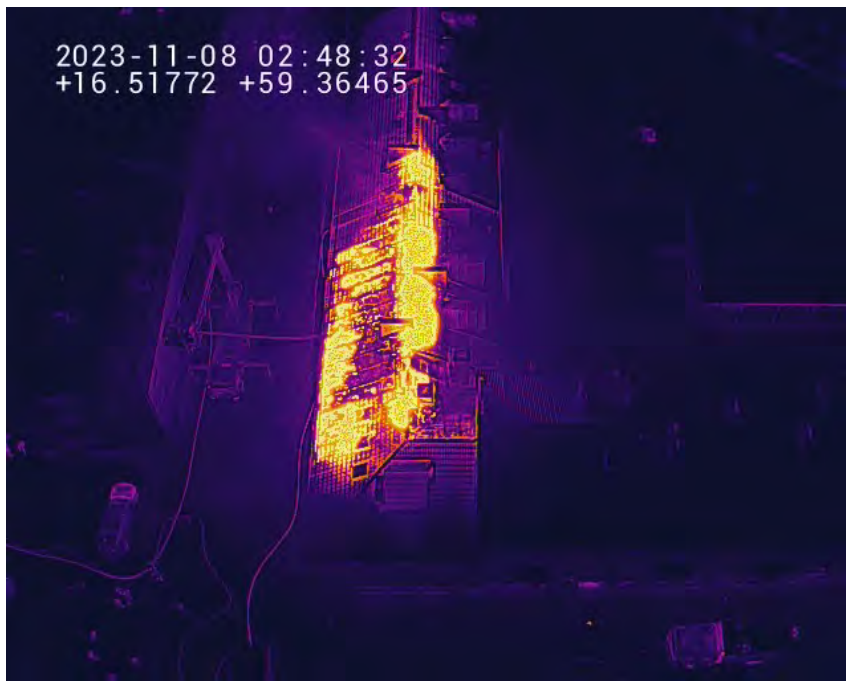
Figur 6. IR-bild från drönare över brandens utbredning klockan 02:48. Längst ned i bild syns korsningen Eskilsgatan-Malmgatan.
