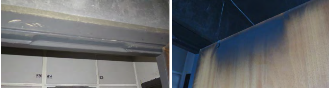
Figur 23 – Överstykke av dörrkarm har ventilationsspringa vilket ger överensstämmelse med sotmönster på dörren.
