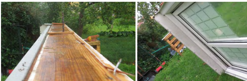
Figur 21 – Sidostycke av karm har varit spikad i betongen. T.h. syns utsidan av fönster. Det var denna sida som låg uppåt efter händelsen (se tidigare figurer). Ingen sot eller andra tecken på brand syns på fönster (har dock legat ute och vänts/hanterats).
