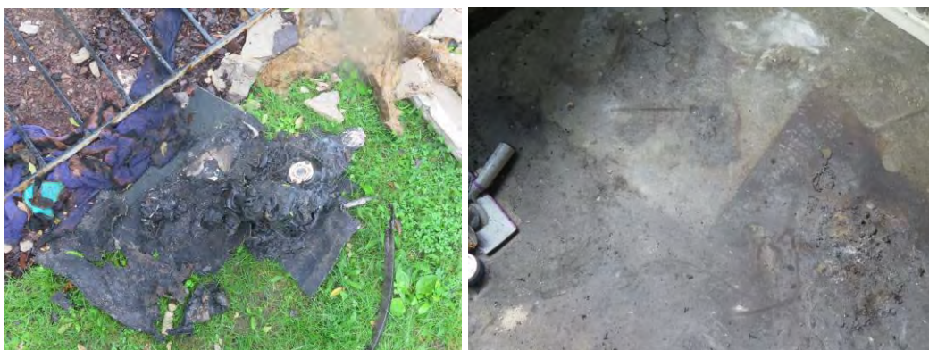
Figur 22 – T.v. syns matta som påträffas bland det lämpade materialet utvändigt. T.h. visas invändigt foto på platsen där matta kan antas ha legat. Se avgränsning, Till höger i denna bild syns området där läckande batteri ska ha varit placerat.
