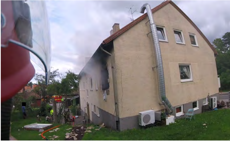
Figur 10 - Bildklipp från hjälmkamerafilm Insatsledare. Vädring med fläkt pågår. Notera fasadmateriell och fönster med utsidan uppåt på marken utanför lägenheten samt spricka i gavelfasaden.
