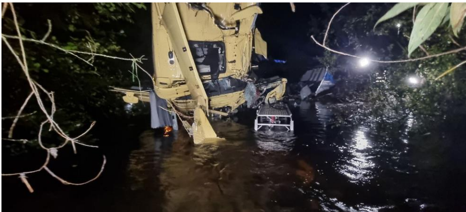
Bild 8. Framifrån med arbetsplattformen.
