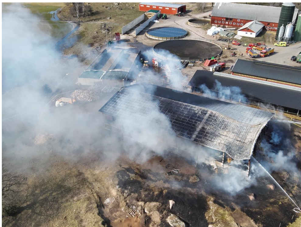
Figur 3. Översiktsbild branddrabbad byggnad, med solceller på tak.
