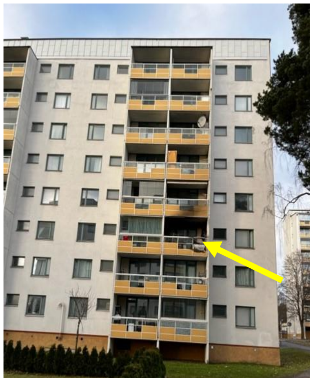
Figur 1. Översiktsbild på huset med aktuell balkong markerad.
