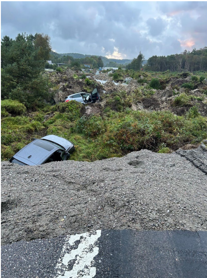
Bild 3 visar skredkanten E6 NG riktning. Källa RSG
