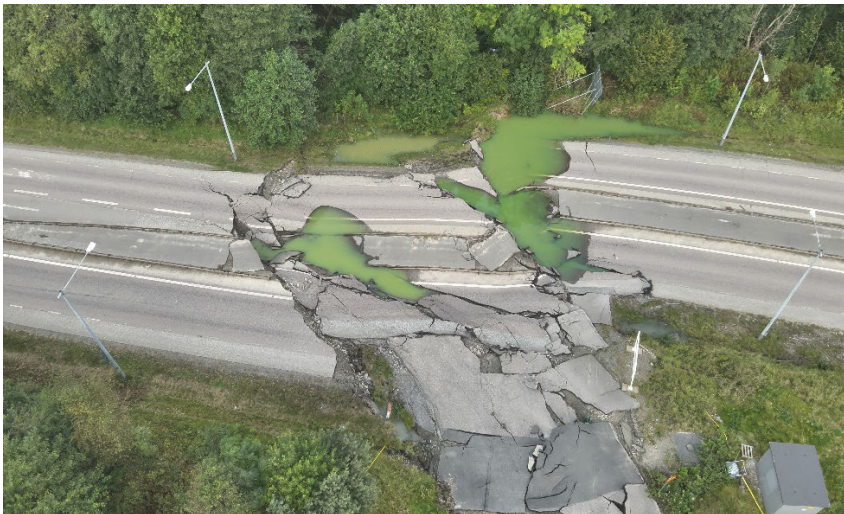
Bild 11 visar tecken på fjärrvärmeläckage. Källa RSG
