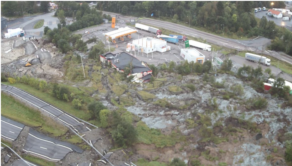
Bild 8, Foto över del av sektor väst inom skadeområdet. Källa RSG
