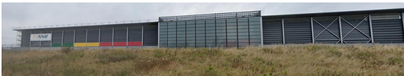
Figur 3 visar byggnaden från Klippanvägen
